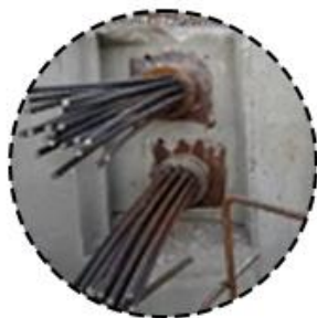
CONCRETO PROTENDIDO VÃOS MAIORES - APROXIMADAMENTE 8M
