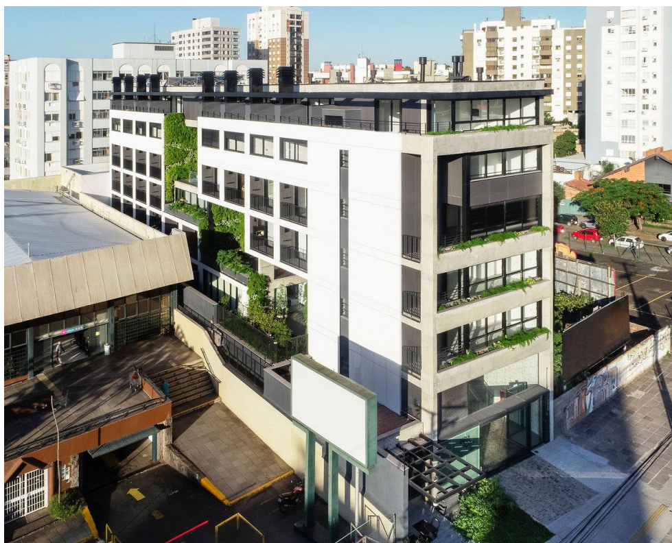
Figura 24: Foto aérea do edifício.
