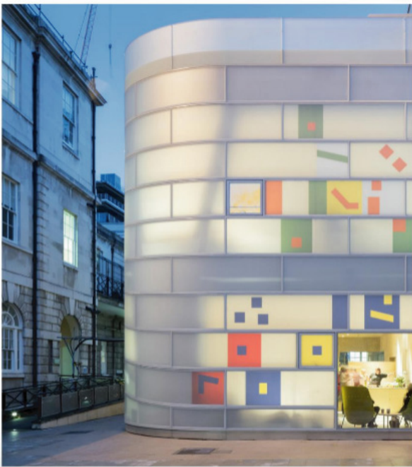
Figura 42: Fachada Maggie's centre barts
