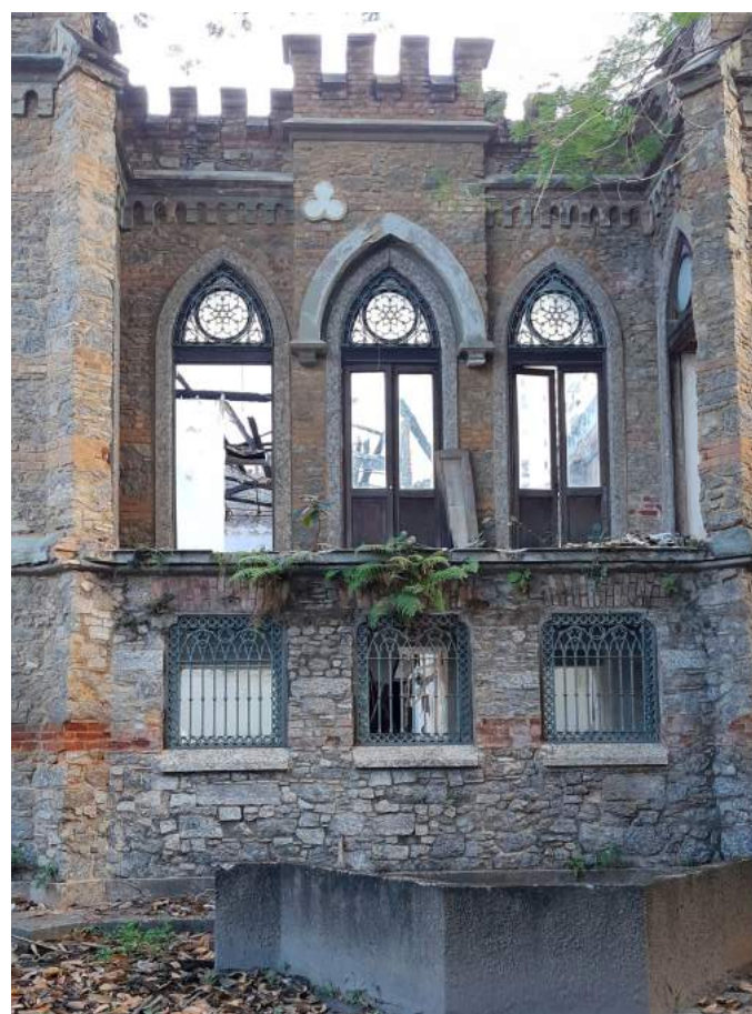
Vista 03 - Trecho central com vegetação acima das janelas, ausência do guarda corpo em ferro, arcada central com superfície degradada, ornato em trevo ausente, cimalthas com mancha negra e porta esquerda ausente de folhas de abrir. Observa-se a presença de gradis nos vãos inferiores e bandeiras das portas
