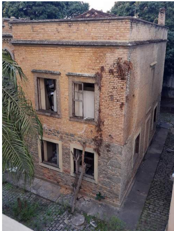
Vista 01 superior - Idem vista inferior, evidenciando também cimalthas com manchas negra. No canto direito da platibanda nota-se a presença de uma chaminé.
