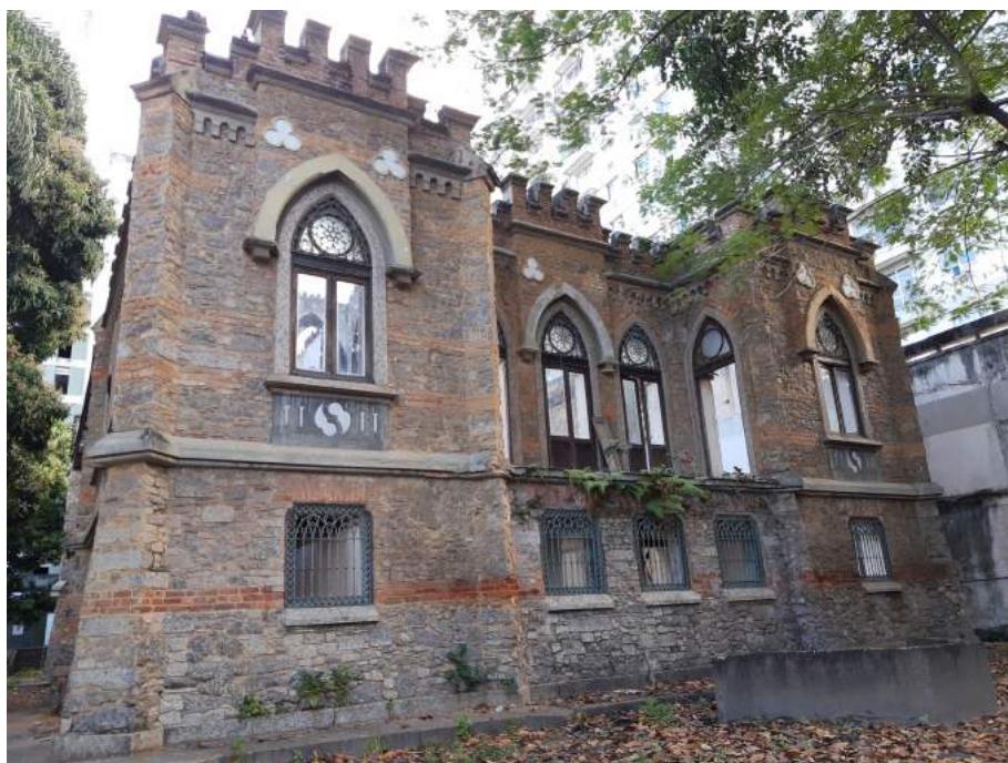
Vista 01 - Vista externa geral.
