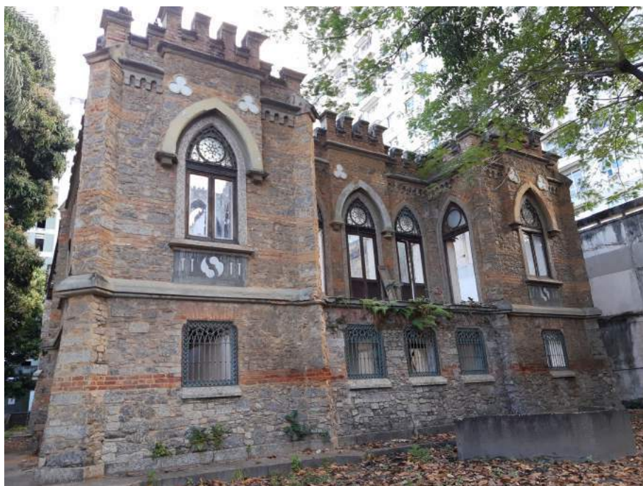
Vista 01 - Vista externa geral.
