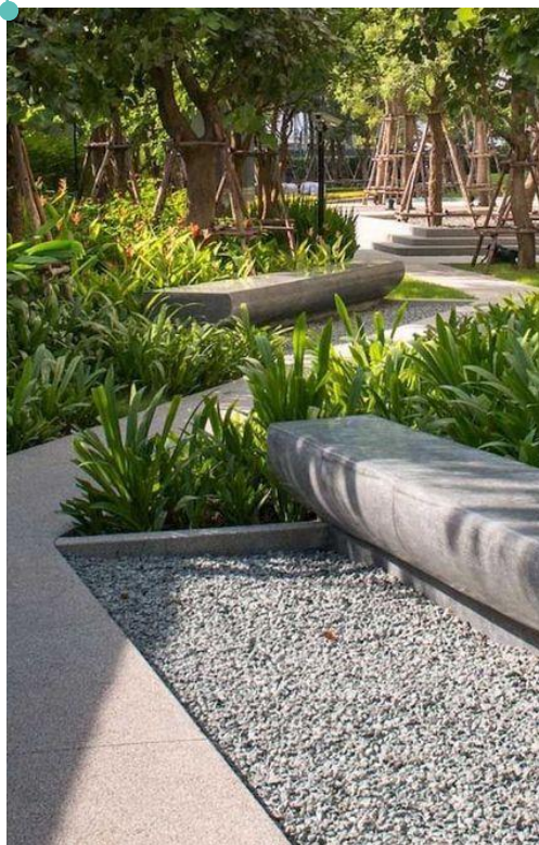
Piso Fulget e tento em meio fio mineral
