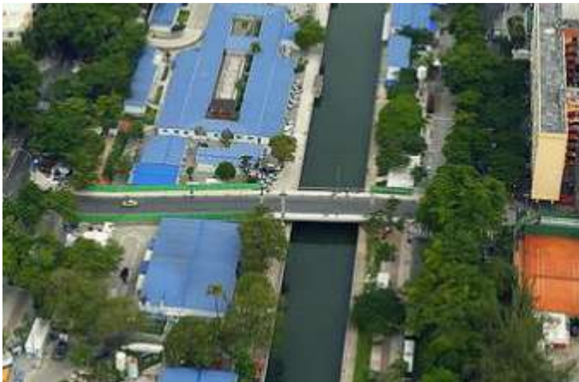
Figura 41: Av. Ataulfo de Paiva interditada para obra da Linha 4
