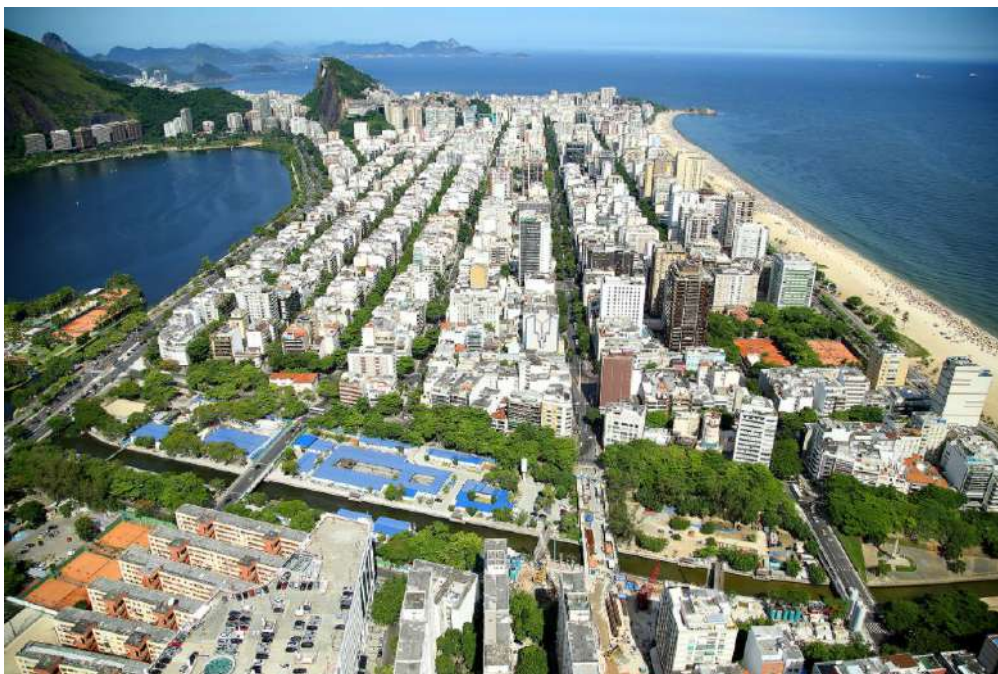
Figura 36: Canteiro de Obras da Linha 4 do Metrô Rio ocupando o parque
