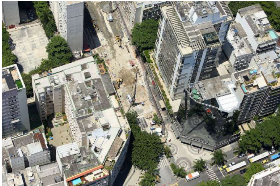
Figura 39: Av. Ataulfo de Paiva interditada para obra da Linha 4
