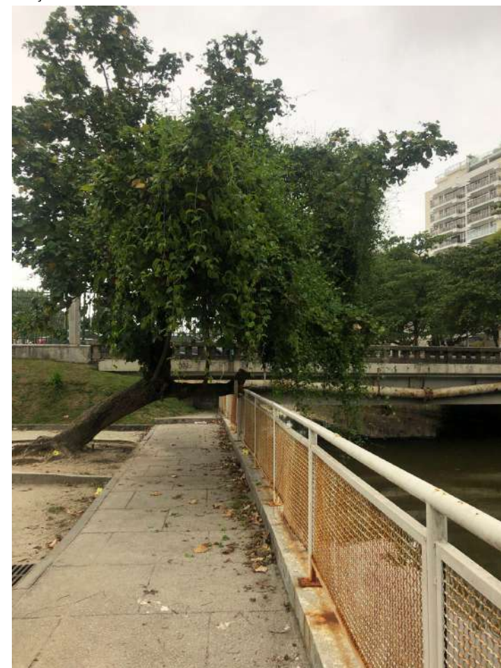
Figura 86: Vista do “Parcão” para a ponte que faz divisa com a Praça Almirante Saldanha da Gama
