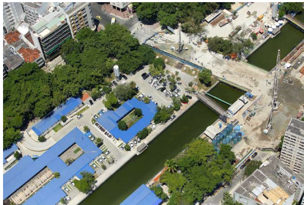
Figura 37: Canteiro de Obras da Linha 4 do Metrô Rio ocupando o parque
