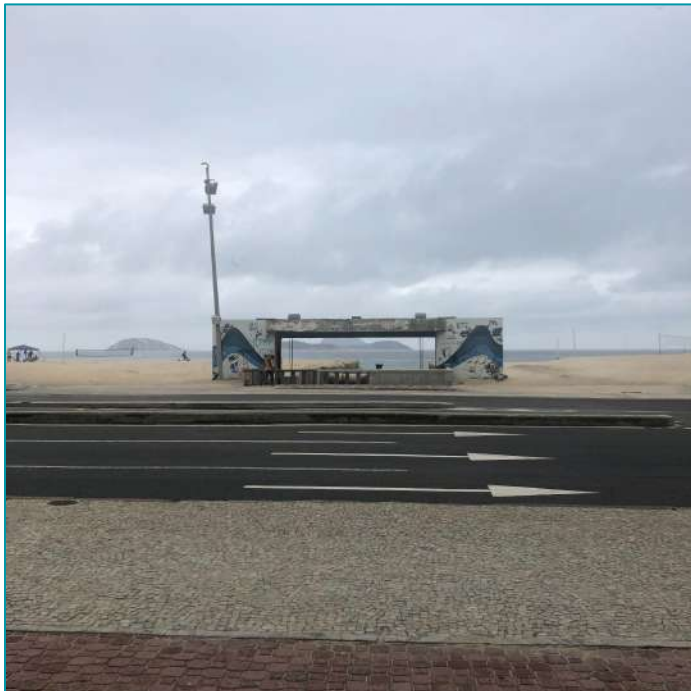
Figura 63: Saída do canal para a praia
