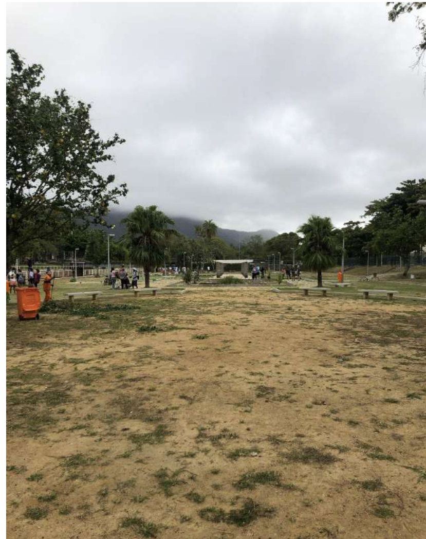
Figura 138: Parte da Praça Grécia que não foi utilizada devido ao seu estado
