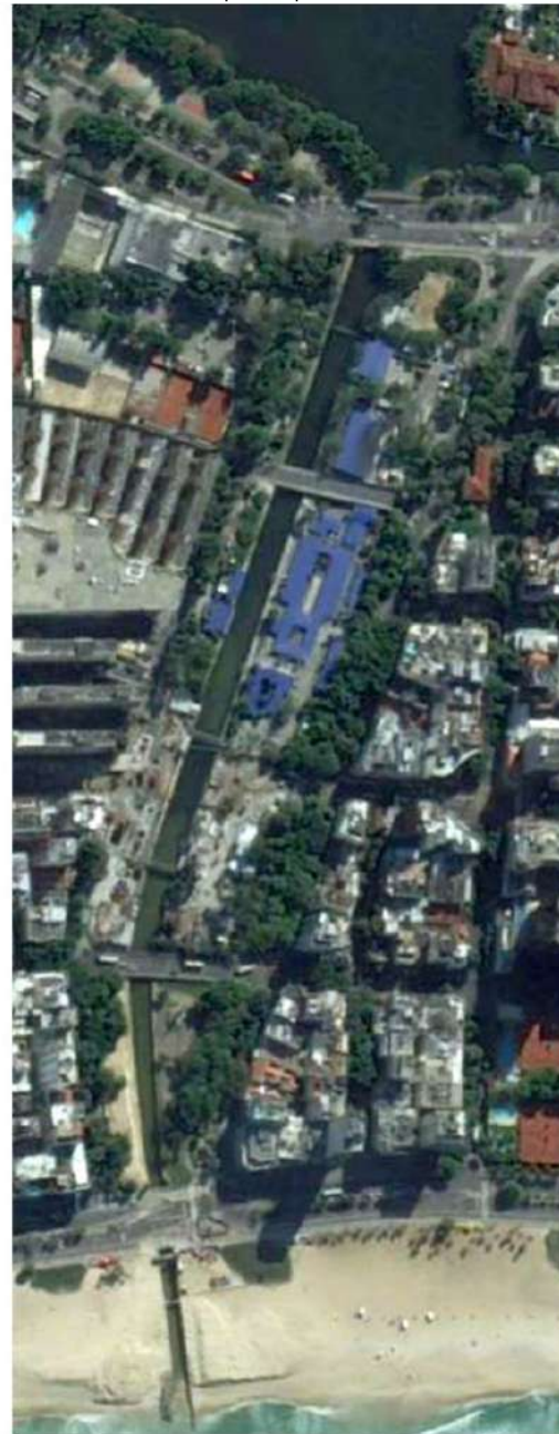
Figura 45: Jardim de Alah em 2015 sendo usado como canteiro de obras para a obra da Linha 4 do metrô. A praça Grécia, a maior delas, é dividida em duas por uma ponte
