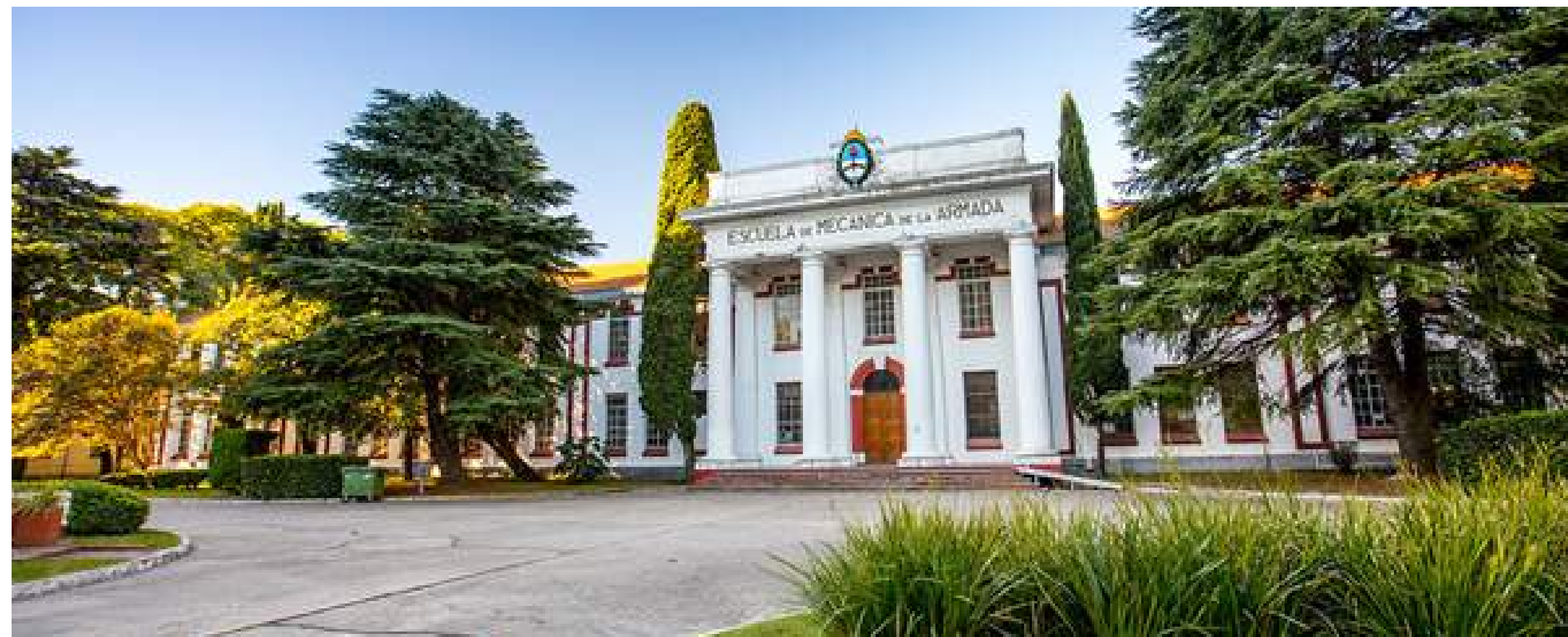
Figura 02 - Foto do edifício principal da ESMA, Cuatro Coluñas, s/d. Fonte: < https://turismo.buenosaires.gob.ar/br/article/percurso-da-mem%C3%B3ria >. Acesso em: 26 de mai. de 2021
