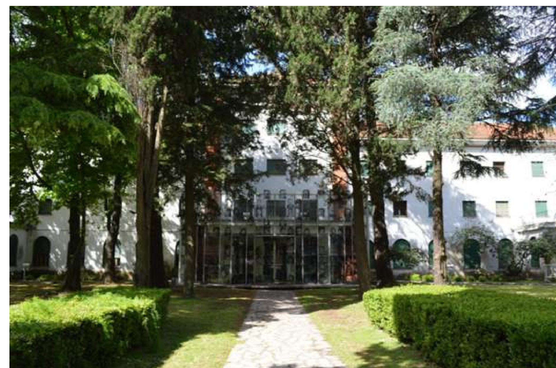
Figura 36 - Fachada do ex Casino de Oficiales. Fonte: GEHRKE, 2017.
