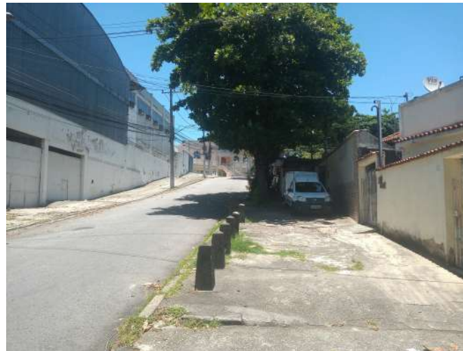
Figura 40: Vista 5, visada da Rua Júlio Maria
