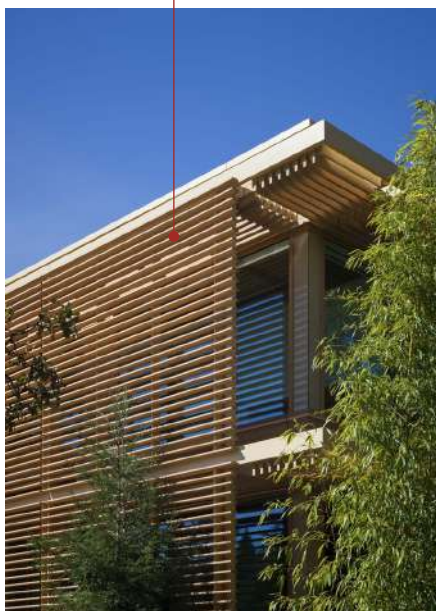
Figura 64: Edifício Sede Venture Capital - Paul Murdoch Architects Fonte: ArchiDaily
