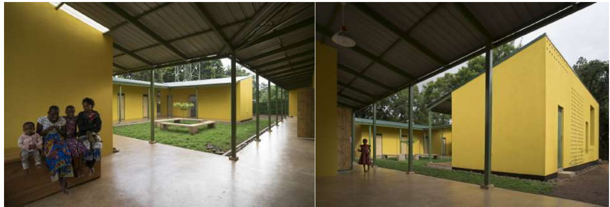
Figuras 24, 25 e 26: Imagens da Casa Albergue KWIECO.
