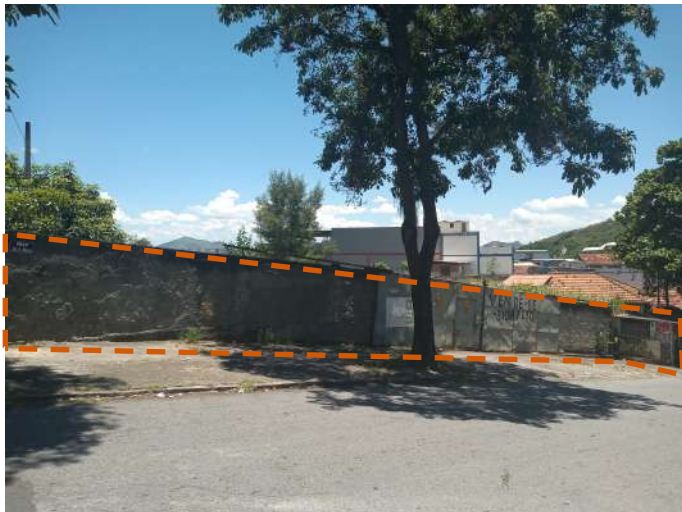
Figura 38: Vista 3, visada do terreno na Rua Júlio Maria
