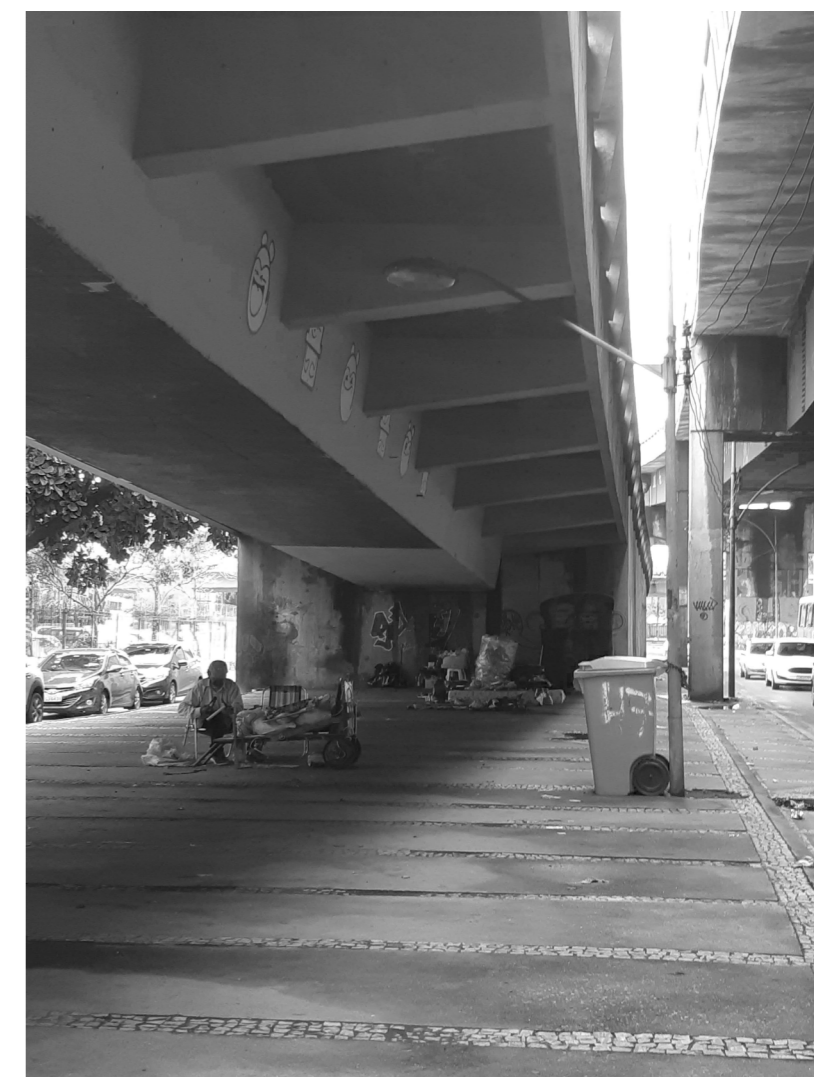
Figura 3 - Perspectiva no atravessamento do elevado Engenheiro Freyssinet pela rua Joaquim palhares no sentido Praça da Bandeira- Estácio. Foto da autora
