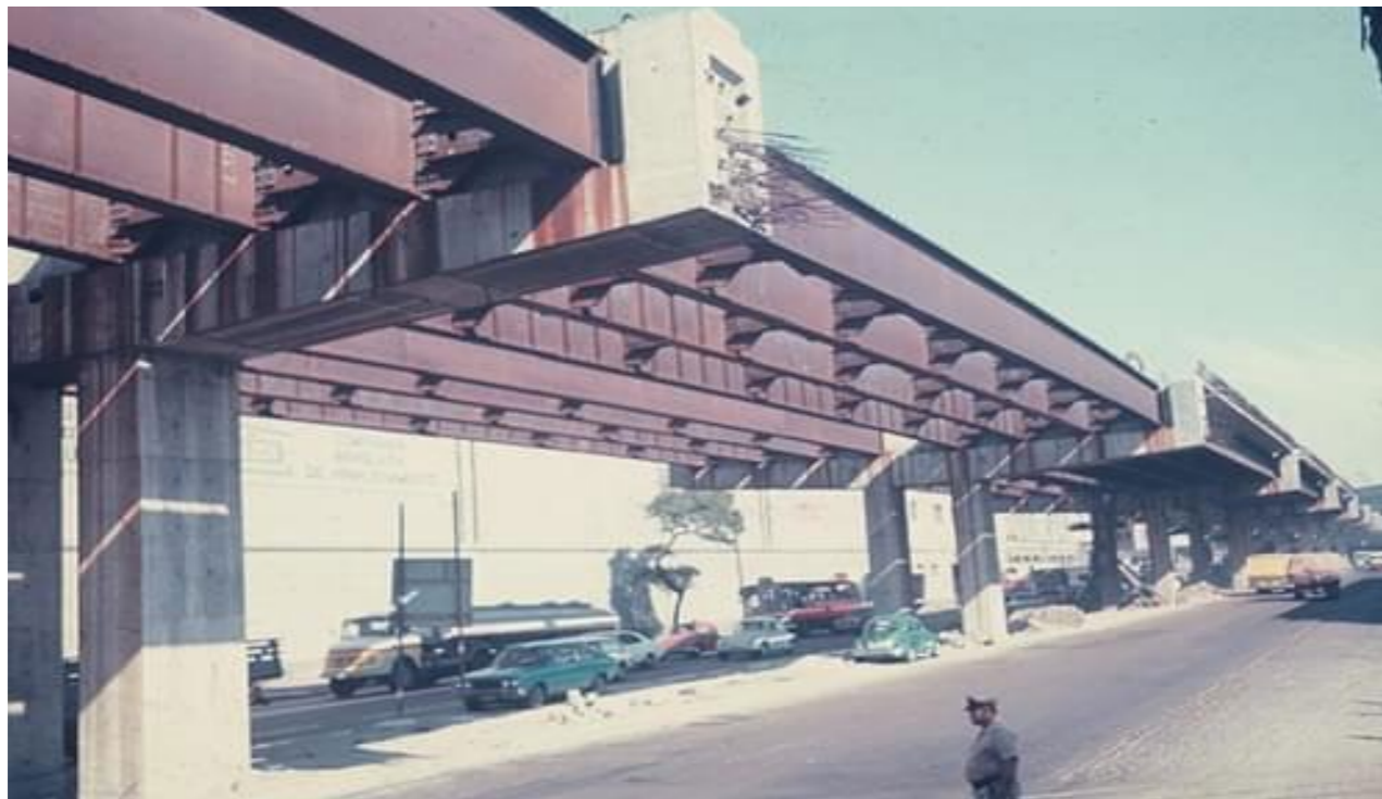
Foto que mostra a estrutura da viga de aço e os pilares de concreto
