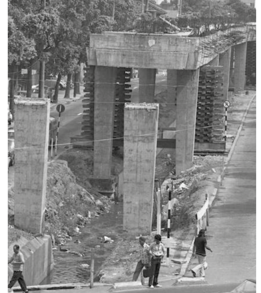
Foto do viaduto com reforços na estrutura para ser reconstruído.
