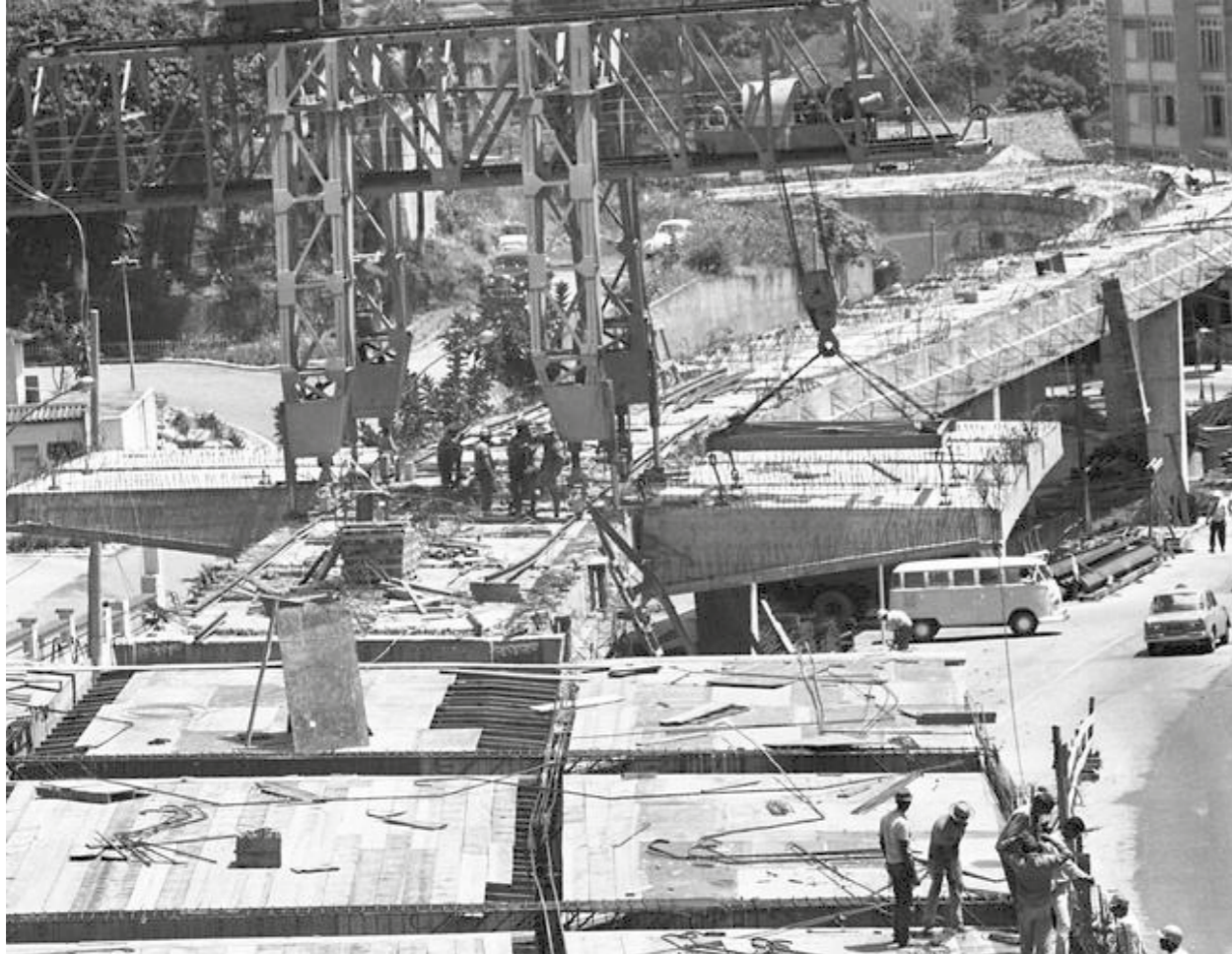
Aduelas sendo içadas pelas pontes.
