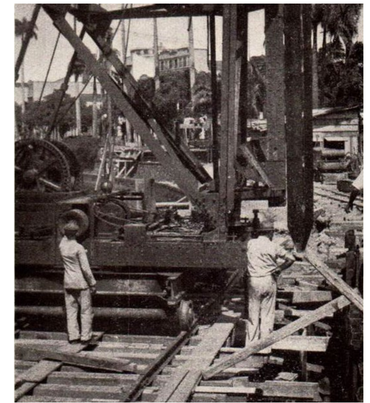
Foto do bate-estaca para execução da fundação profunda.
