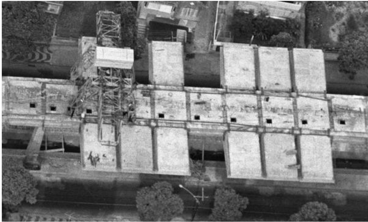
Aduelas sendo içadas pelas pontes.
