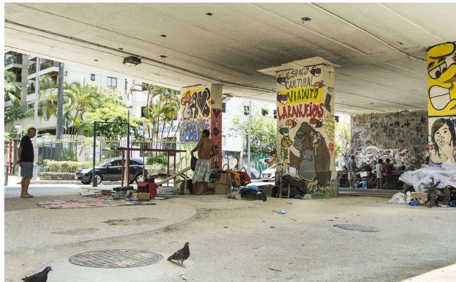
Ocupação sob viaduto Viaduto Eng. Noronha, Laranjeiras-RJ
