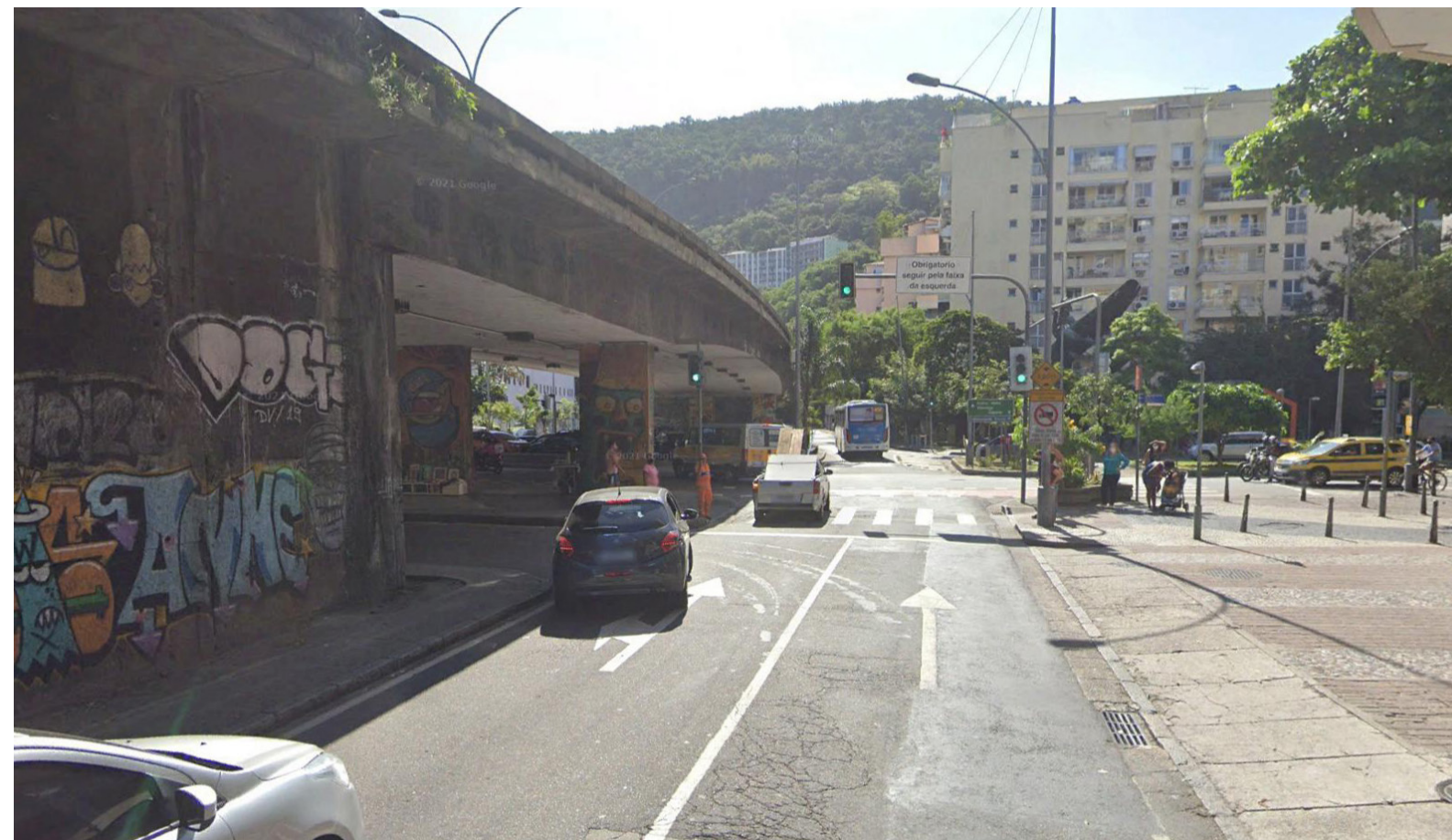
Visada da parte inferior do viaduto pela rua Pinheiro Machado.
