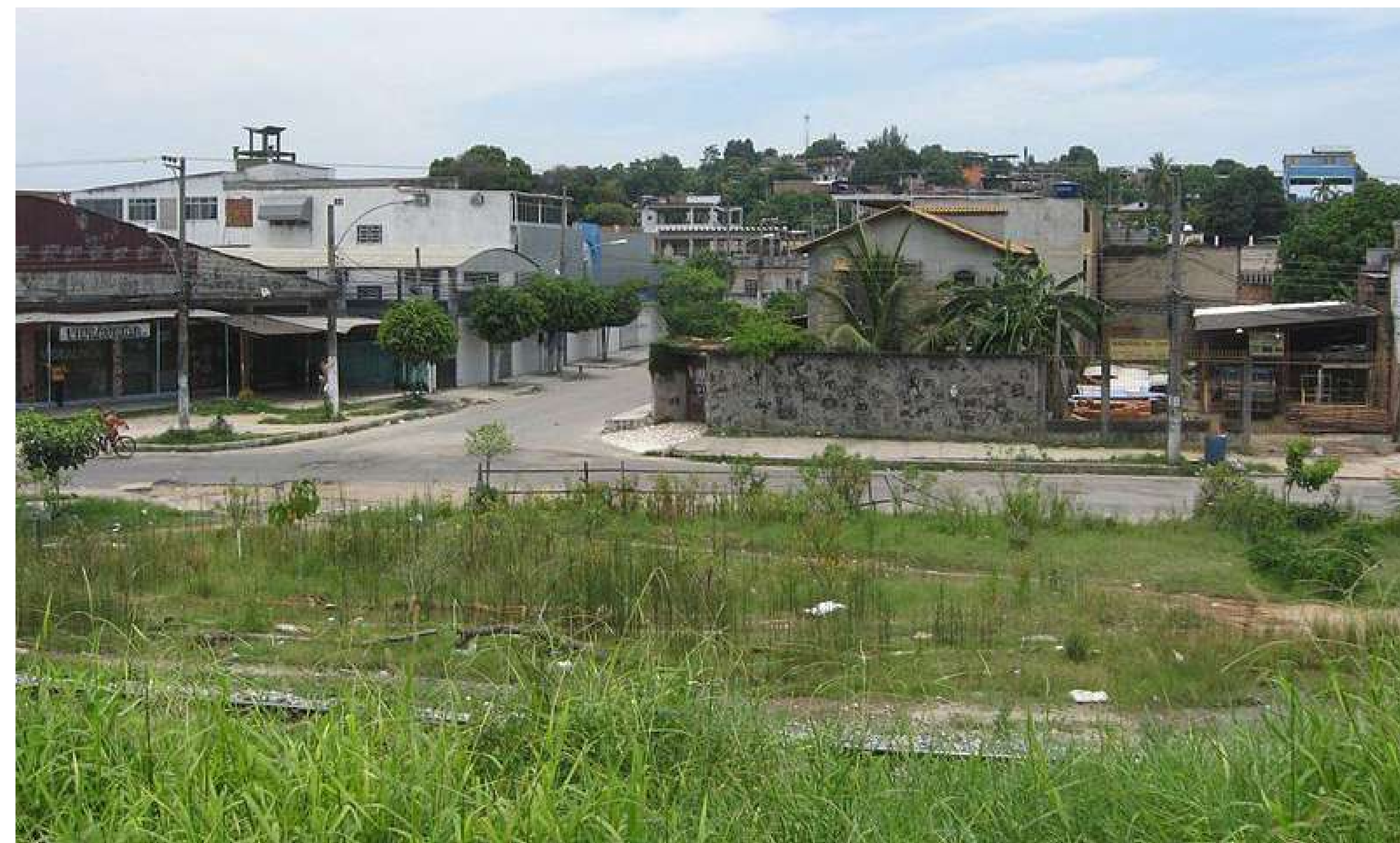
Linha de trêm desativada São Mateus, São João de Meriti-RJ
