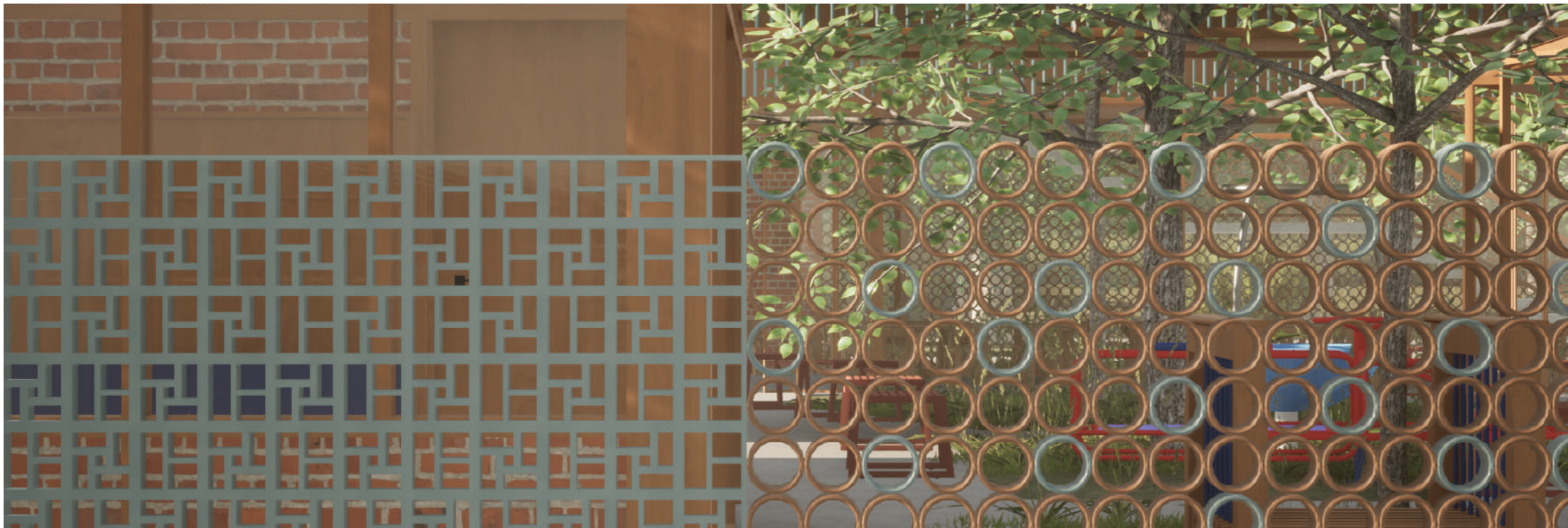
COBOGÓS CERÂMICOS COM PINTURA AZUL
