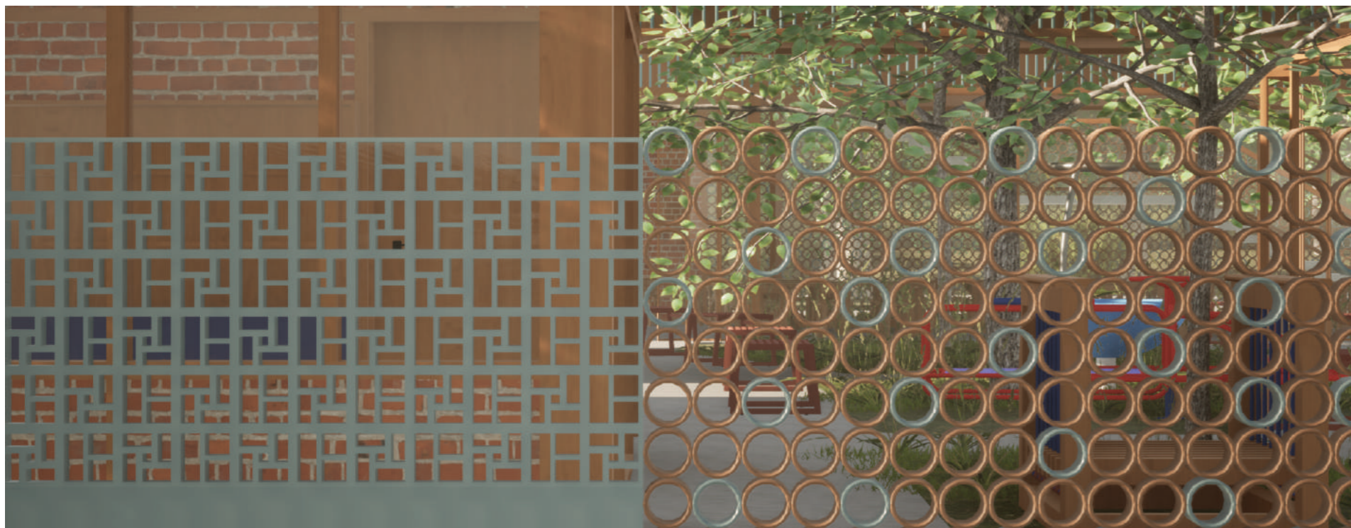
COBOGÓS CERÂMICOS COM PINTURA AZUL
