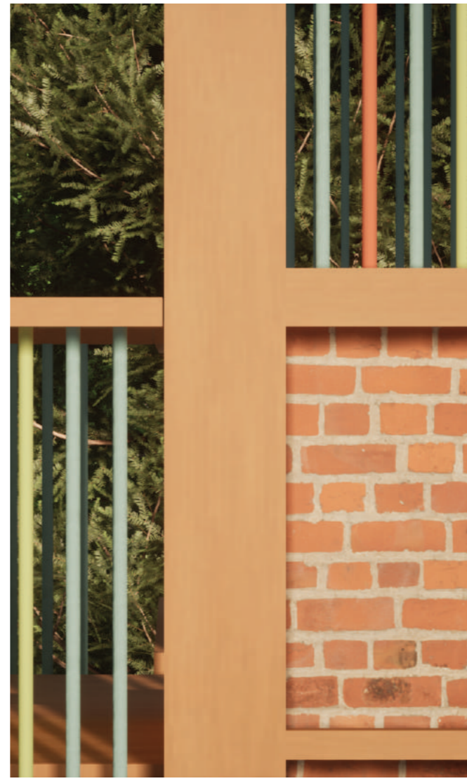
ALVENARIA APARENTE, MADEIRA E PINTURA AZUL
