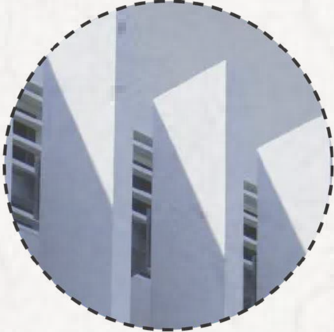
Brise de concreto reforçado com fibra de vidro 40Lx350Ax6E Betsinor
