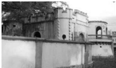
Uma das estruturas da antiga fábrica (data e autor desconhecidos) - (fonte: bairroderealengo.blogspot.com)
