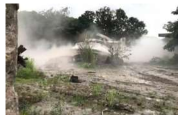
demolição das antigas edificações fabris para futuro empreendimento na área (fonte: realengoempauta.com.br )
