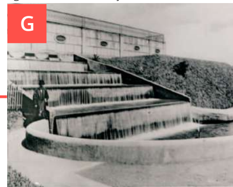
figuras x e x: cascata de aeração na caixa alta
