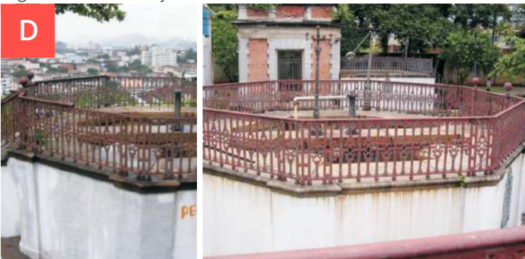
figuras x e x: caixas de passagem da água das adutoras de Rio D'ouro
