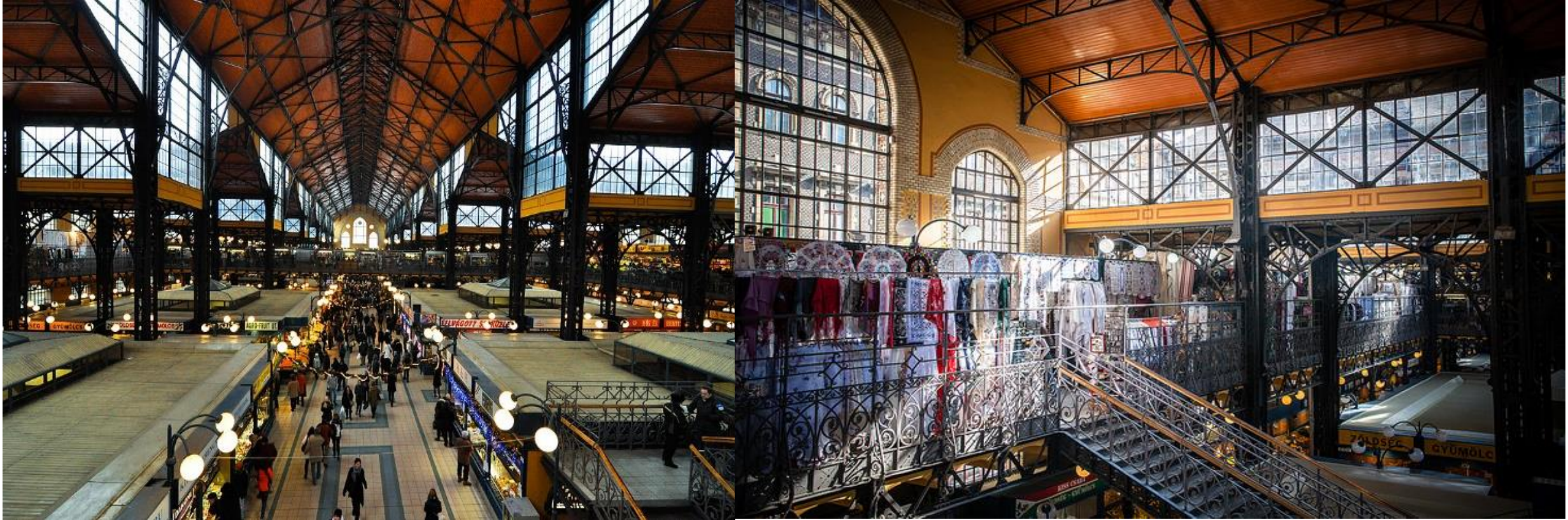
Imagens com vistas internas do mercado, ressaltando a predominância da estrutura metálica e de uma cota elevada. Fonte: Markus Kolletzky, 2014.
