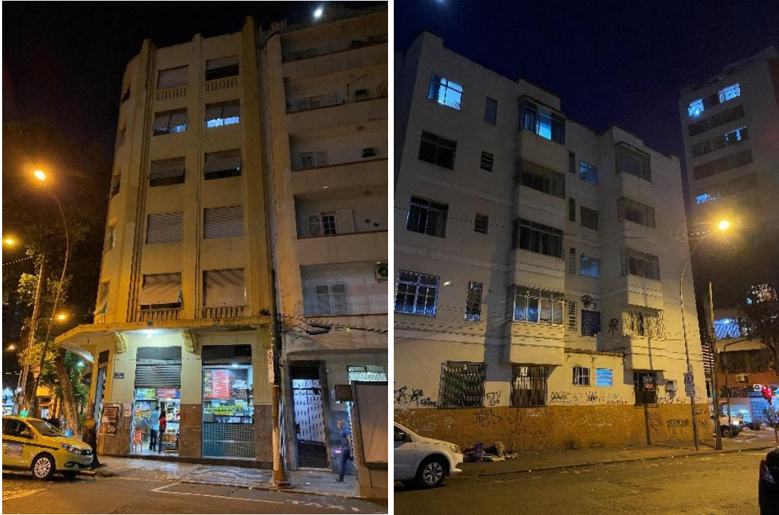
Figuras 69 e 70 – Fotografias da Rua Carlos Sampaio, ambas às 19 horas, realizadas durante a visita que a autora fez à área junto com o Grupo de Pesquisa LabLugares, Proarq – FAU UFRJ.
