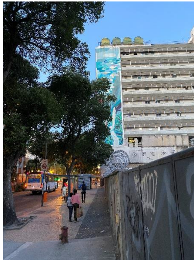
Figura 53 - Fotografias da Avenida Henrique Valadares nº 100, aproximadamente.
