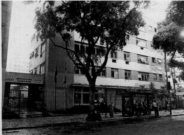
VAI ABAIXO! – Prédio que abrigava instalações do Iaserj será demolido na Avenida Henrique Valadares
