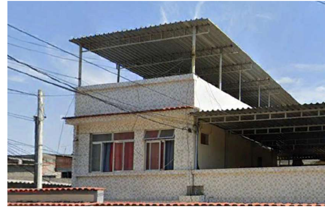
Estruturas leves em telheiros no entorno da VULCAN. Imagem 1: Favela do Para Pedro. Imagem 2: Rua Dúlio Costa
