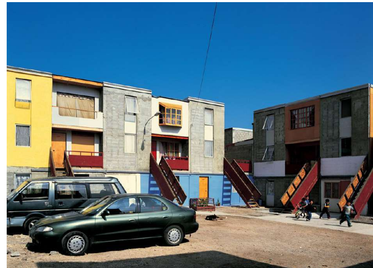
Figura 36: Projeto social de Aravena: Quinta Monroy - Iquique, Chile. Disponível em: < https://www.archdaily.com.br/br/01-28605/quinta-monroy-elemental >. Acesso em dezembro de 2020.
