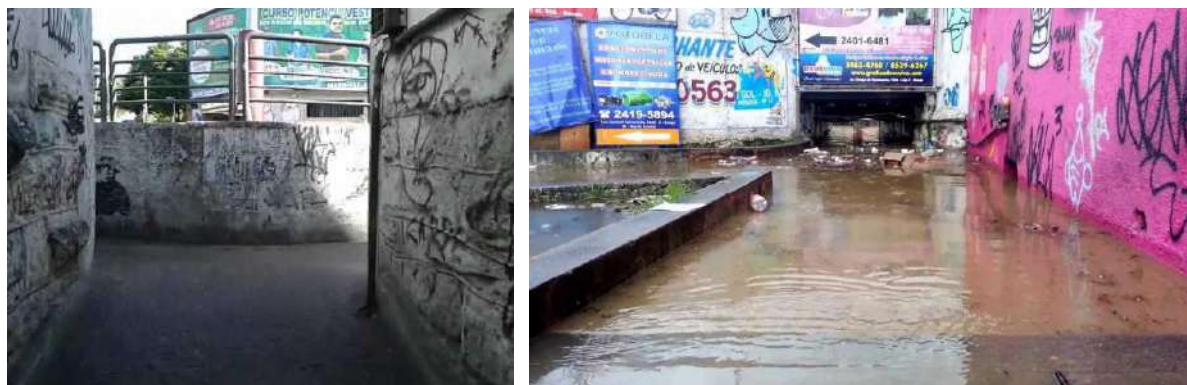
O Buraco do Faim, uma das passagens entre os lados da linha férrea, é estreito, e não possui iluminação. Contudo é acessível para ciclistas e pessoas com baixa mobilidade. O local é passível de alagamento em épocas do ano com muita chuva, apesar de possuir ralos para drenagem [64] e [65].
