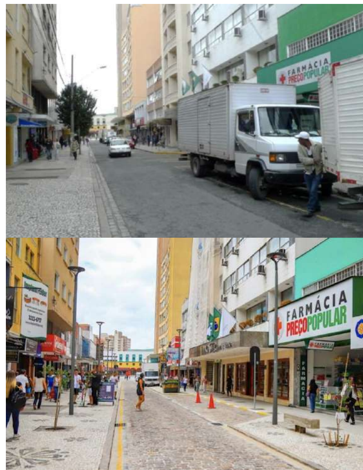
Rua Voluntários da Pátria antes e depois da reforma [158] e [159].
