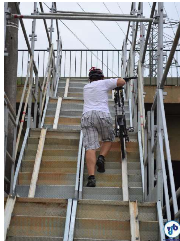
Caneleta metálica instalada em escada para permitir o acesso aos ciclistas.
