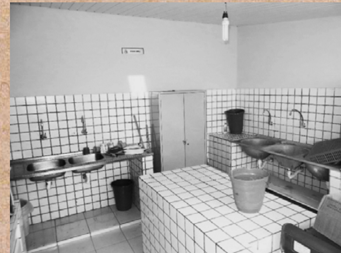
Fig. 8 - Lavanderia e espaço de refeição. Fonte: Imagem retirada de BARROS, pág. 50, 2015.
