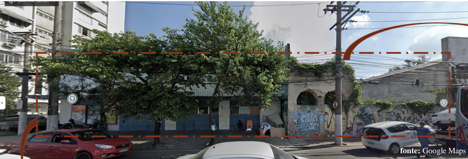
Fachada principal na Rua Marechal Deodoro
