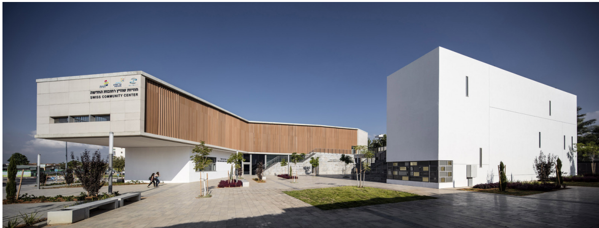
Figura 30 - Centro Comunitário Rehovot: Relação do edifício com a praça interna.
