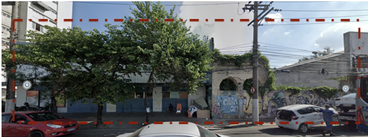
Figura 13 - Fachada principal do terreno proposto, na Rua Marechal Deodoro.
