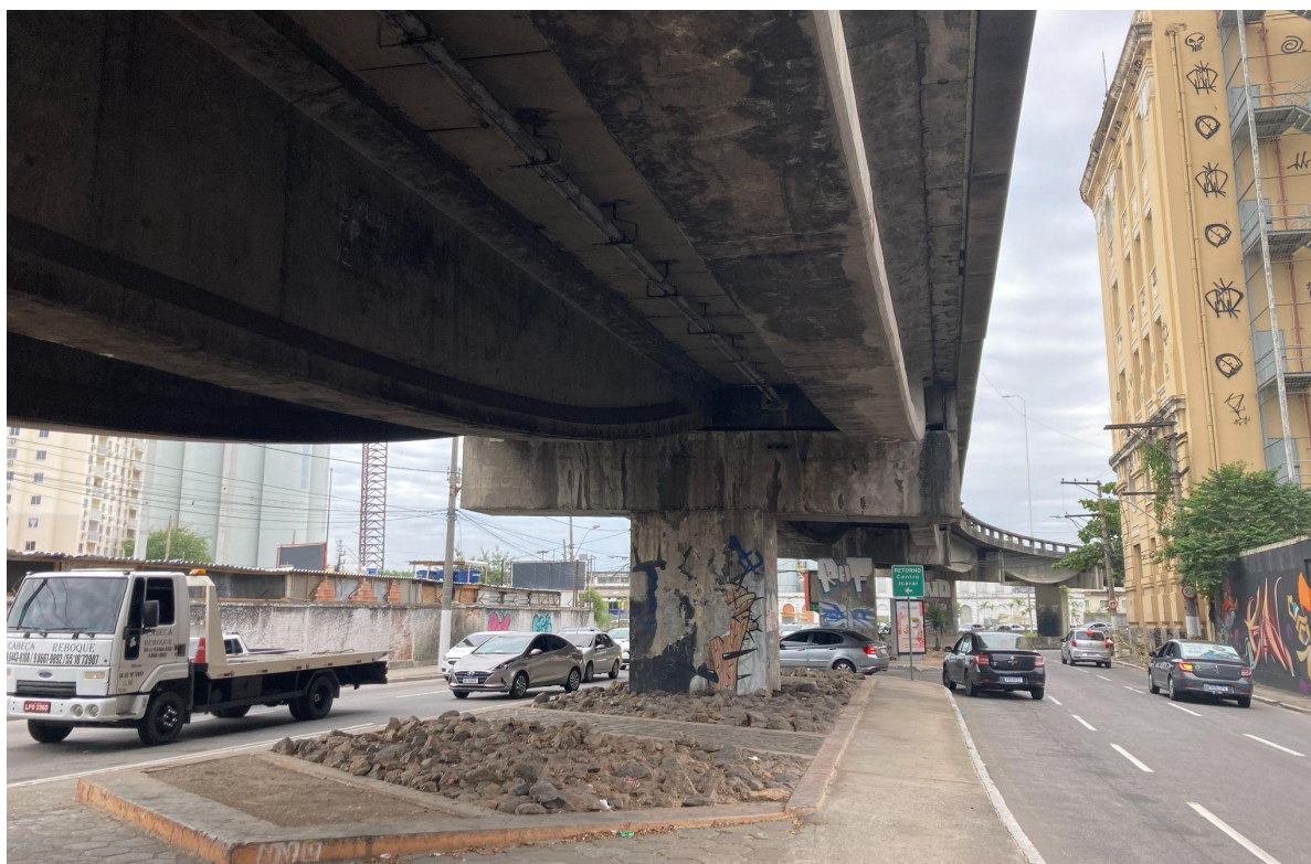
Figura 01 - Pedregulhos instaurados nas bases dos viadutos de acesso à Ponte Rio- Niterói.
