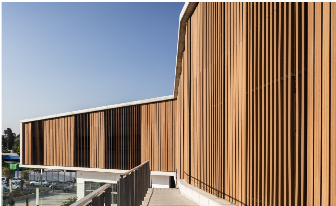
Figura 31 - Centro Comunitário Rehovot: Fachada com brises.
