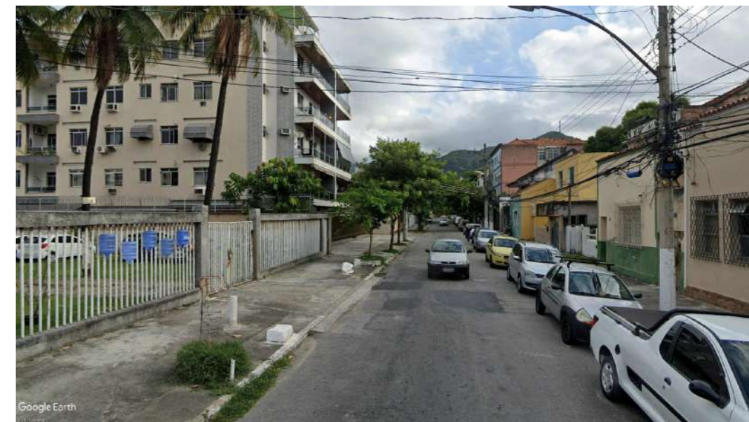
Relação do terreno com as edificações do entorno. Fonte: Google Earth, 2021.
