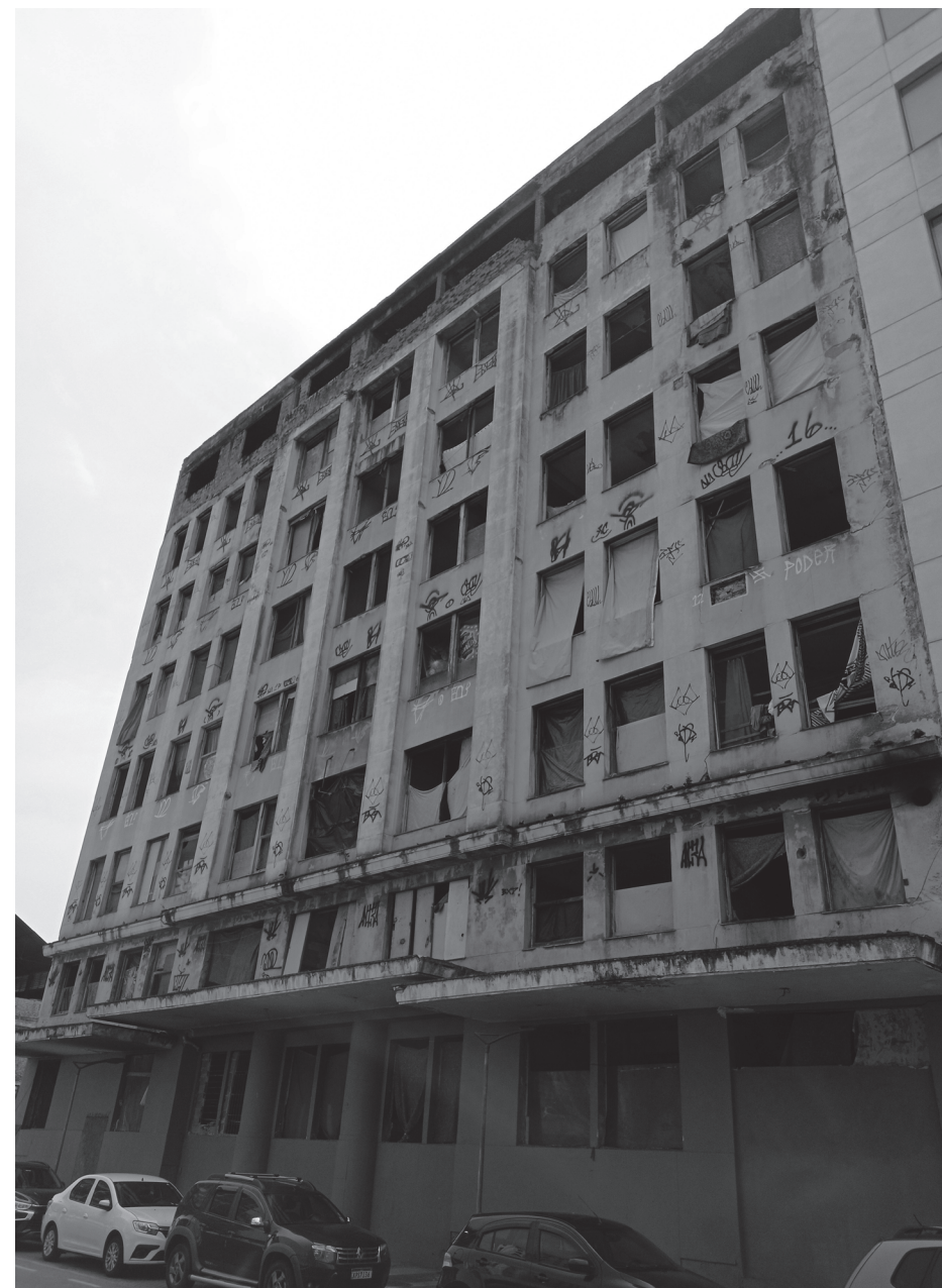
Figura 16: Fachada secundária do edifício. Foto pela autora
