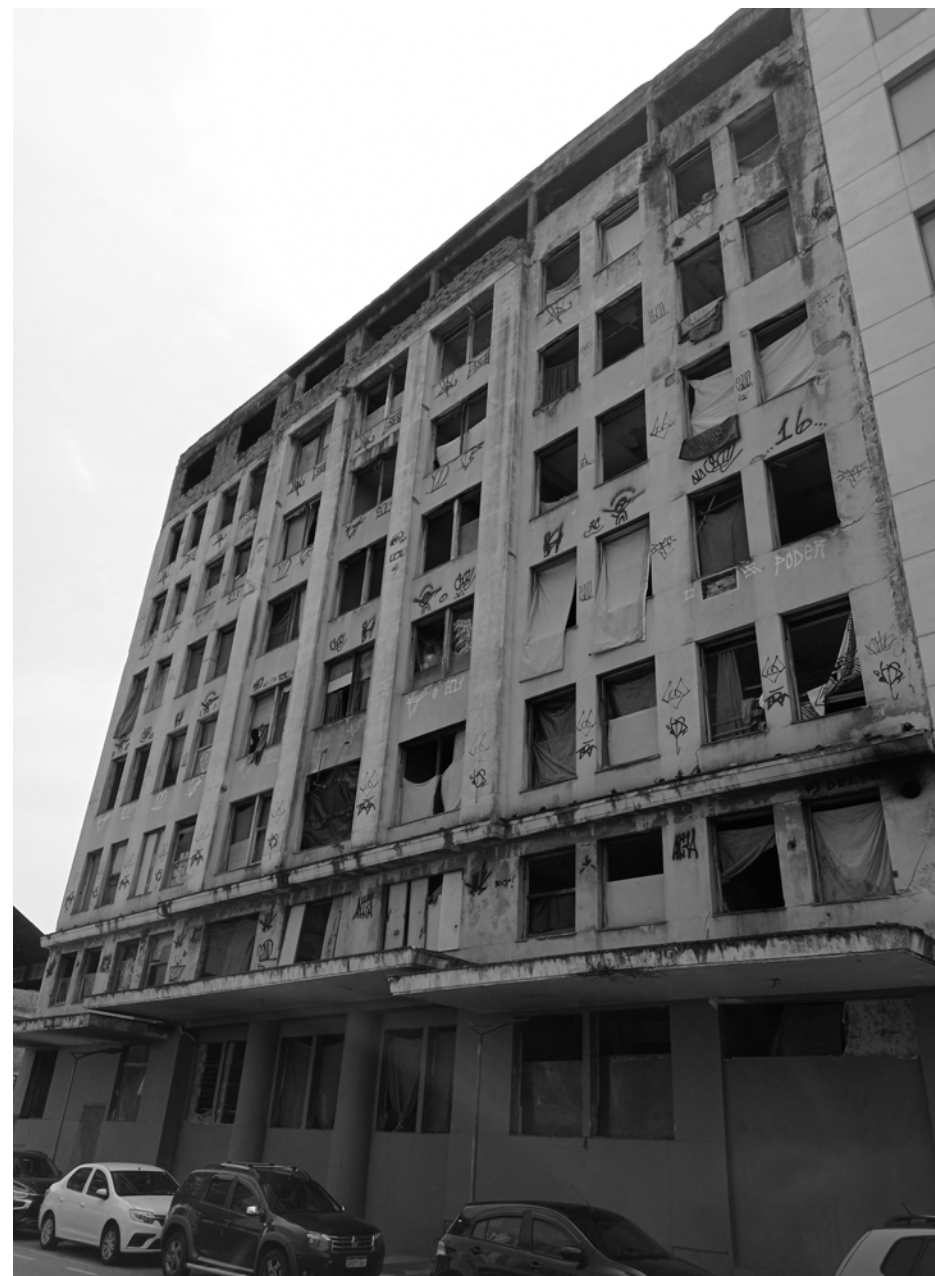
Figura 16: Fachada secundária do edifício. Foto pela autora
