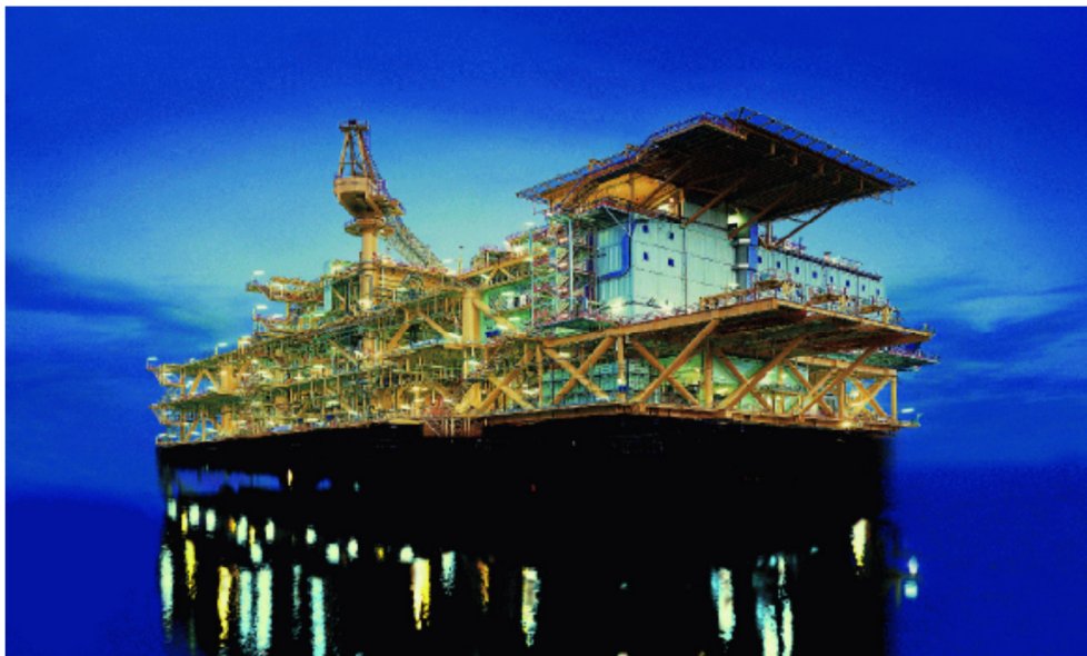
Figura 9: Plataforma de Cakerawala com sistema de remoção de gás ácido instalada no Golfo da Tailândia.
