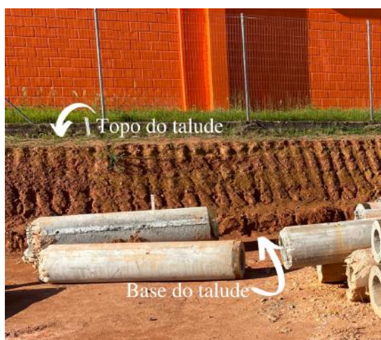
Figura 21 Talude presente no terreno (Autora)
