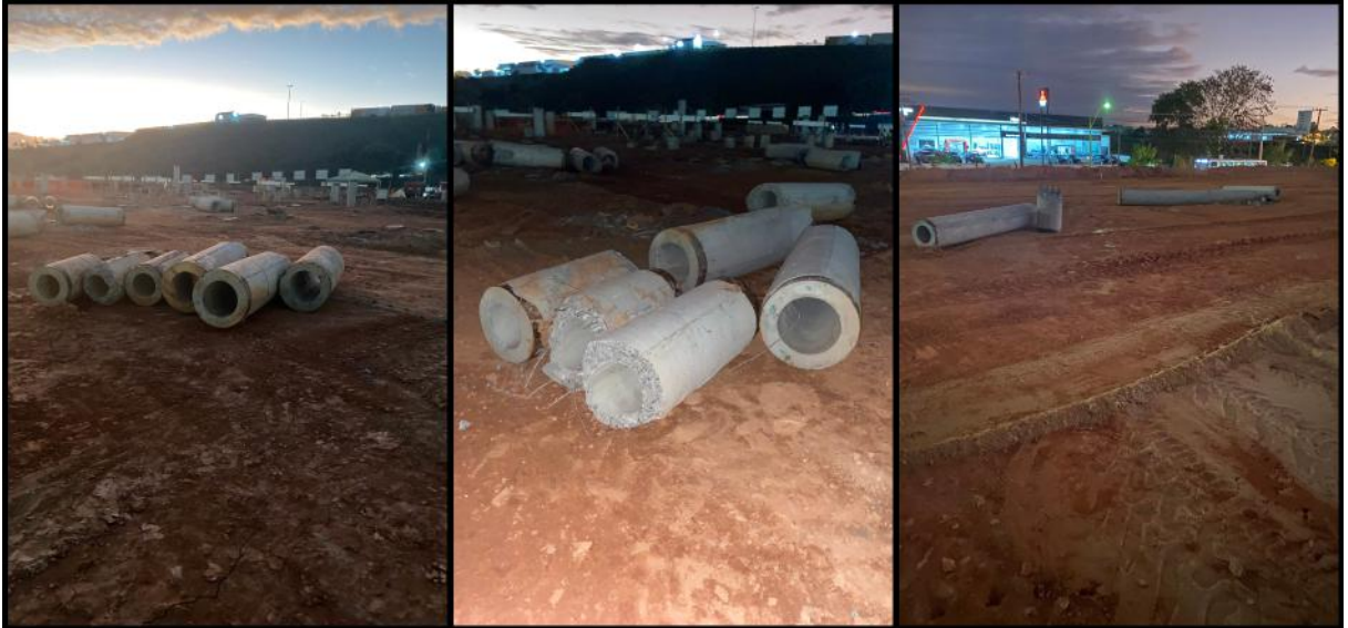
Figura 15 Estacas dispostas próximas aos seus pontos de projeto; (Autora)
