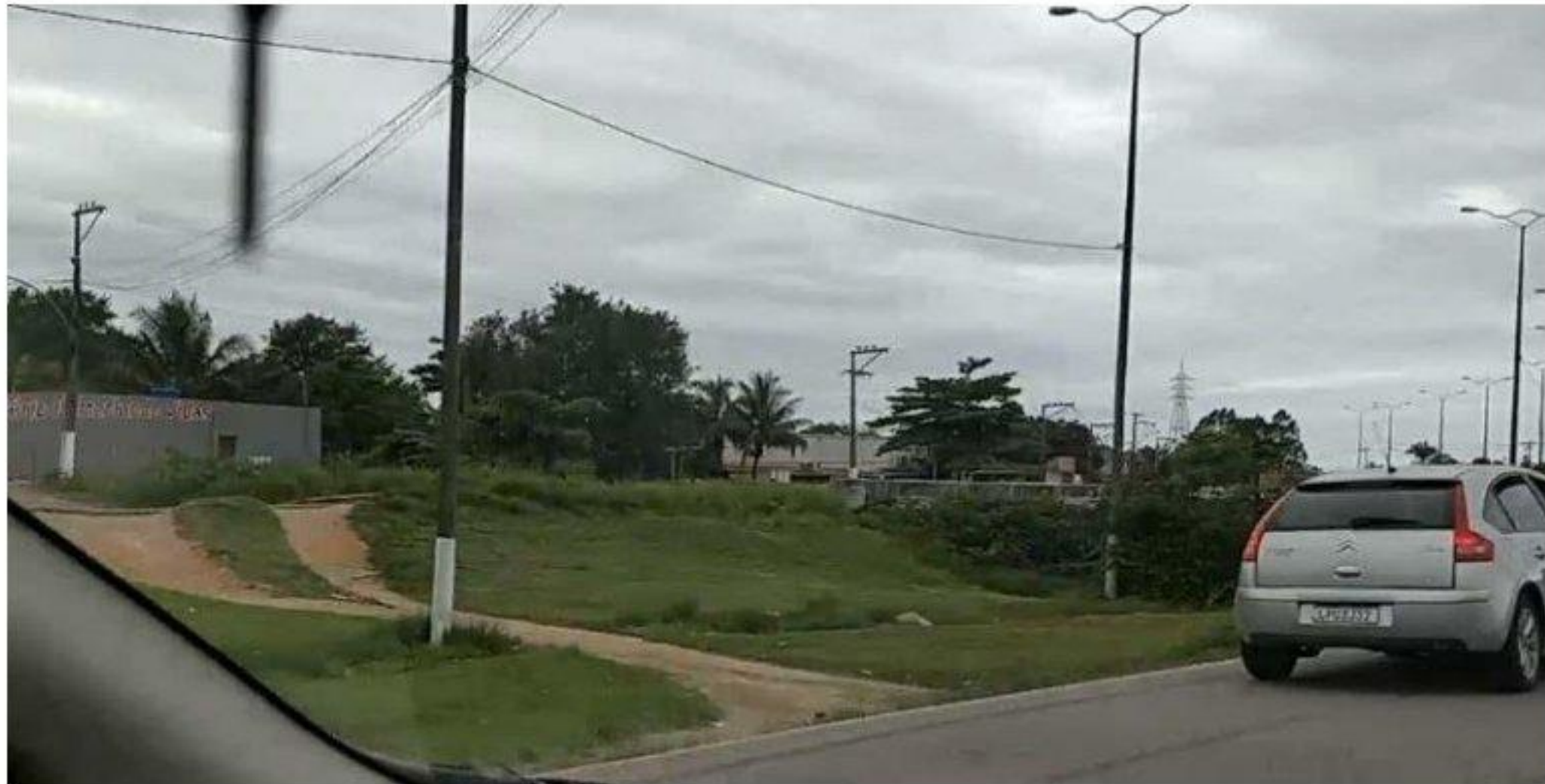
Fotografia 5 - Retorno irregular no canteiro central. Fonte: Própria autora
