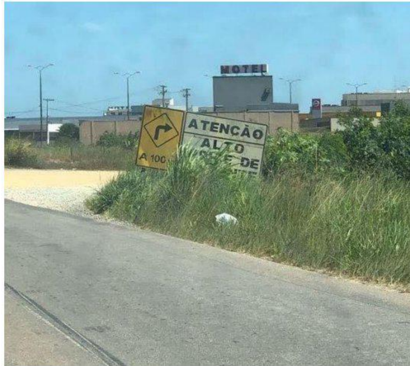
Fotografia 8 - Placa de atenção para alto risco de acidente coberta por vegetação. Fonte: Própria autora
