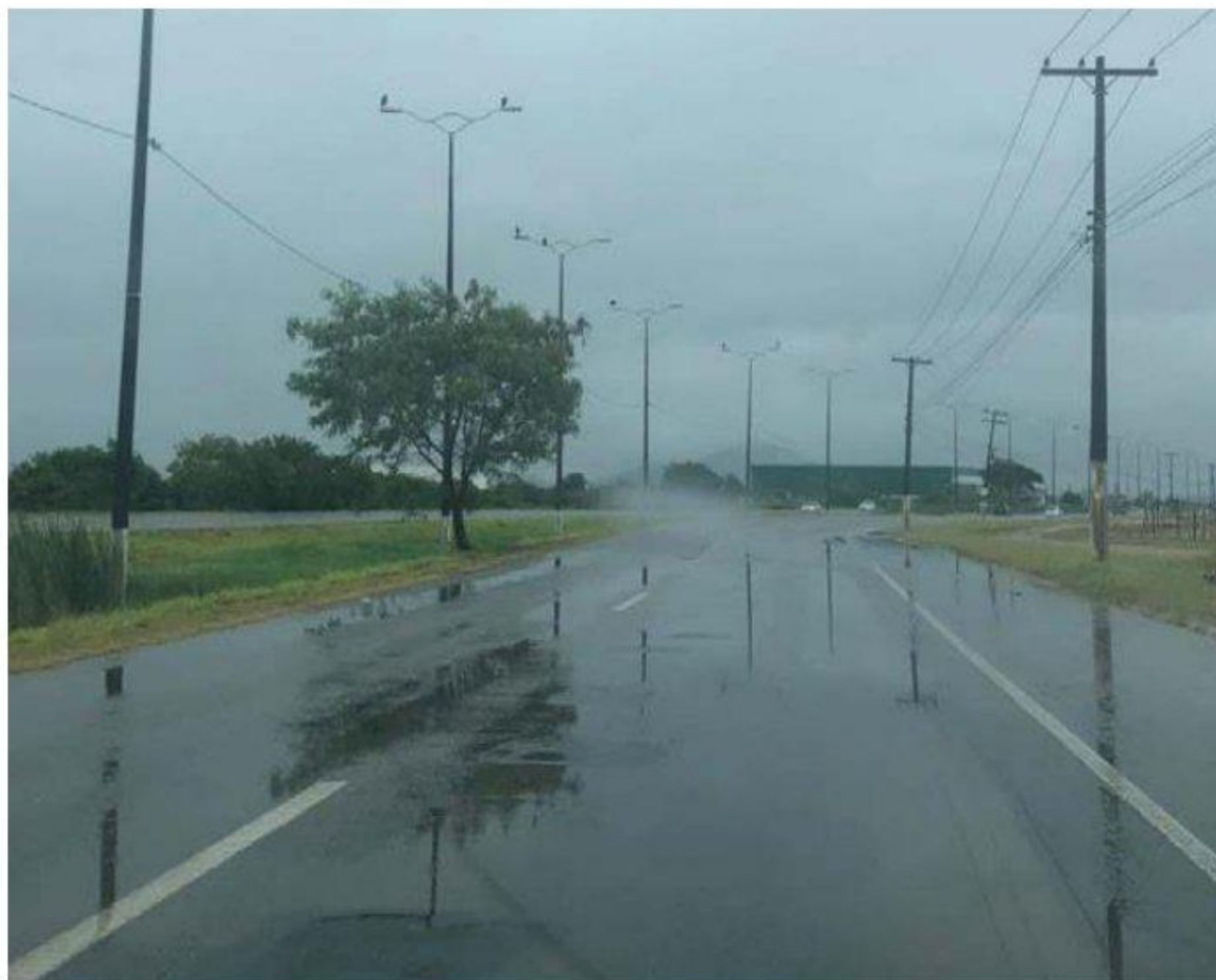
Fotografia 16 - Pista com acúmulo de água da chuva. Fonte: Própria autora
