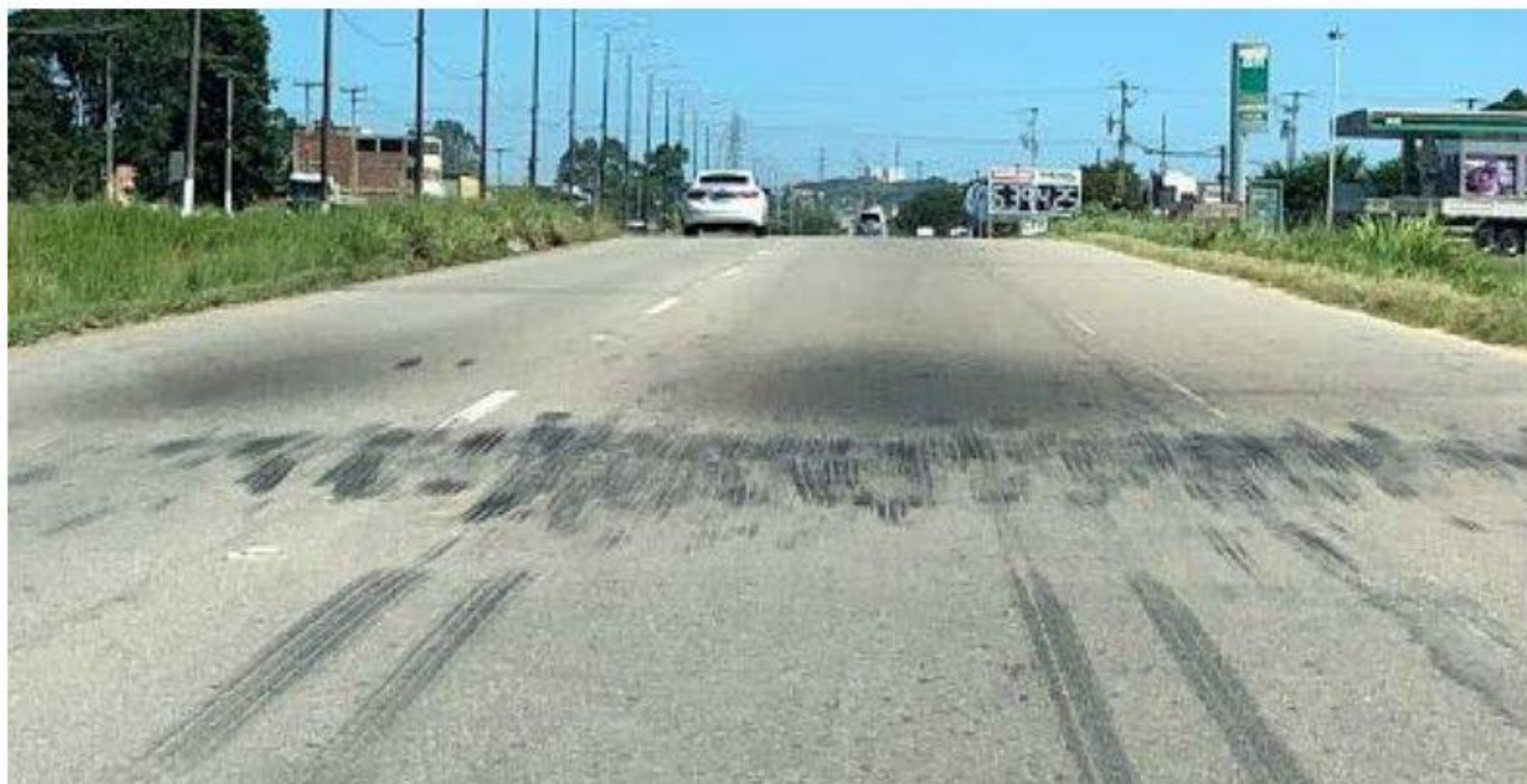
Fotografia 14 - Afundamento na pista de rolagem. Fonte: Própria autora
