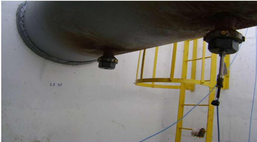
Figura 4 – Pontos de monitoramento por perda de massa (à esquerda) e sonda de resistência elétrica (à direita) (Relatório de Integridade de Dutos - Transpetro, 2011)
