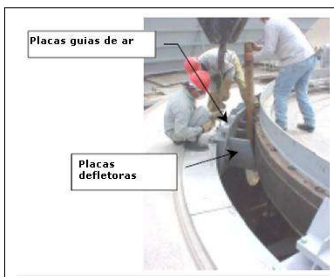
Figura 6.20 - Instalação de chapas (Lafarge, 2007)
