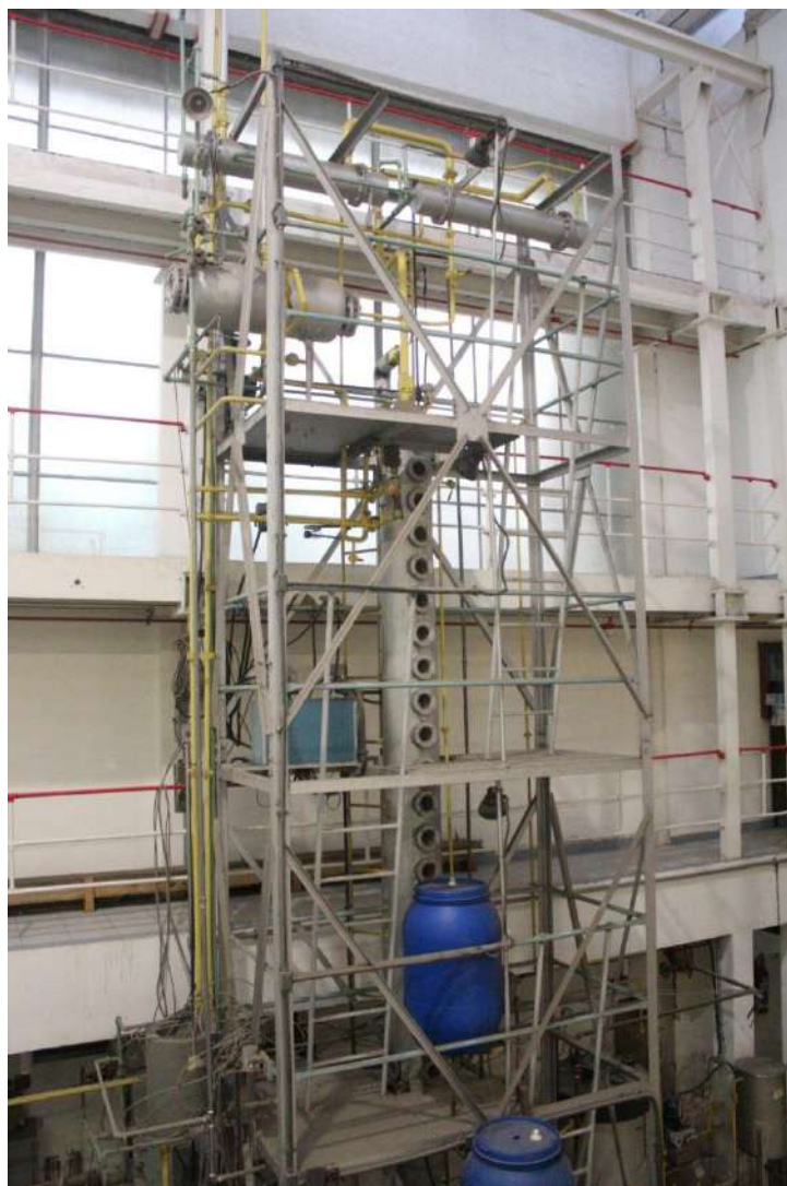
Figura 14 - Condensadores, vaso de condensado e a coluna de destilação.
