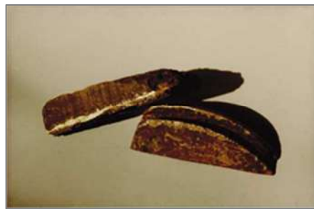
Figura II.9 - Corrosão grafítica em ferro fundido cinzento (GENTIL, 2007).
