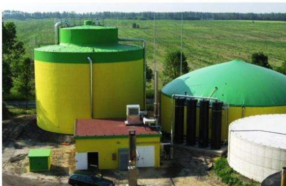
Figura 2.6: Biodigestor de resíduos alimentares em escala industrial (CUBA, 2009).
