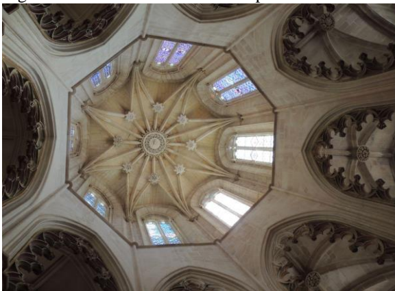
Figura 9: Abóbada estrelada na Capela do Fundador.
