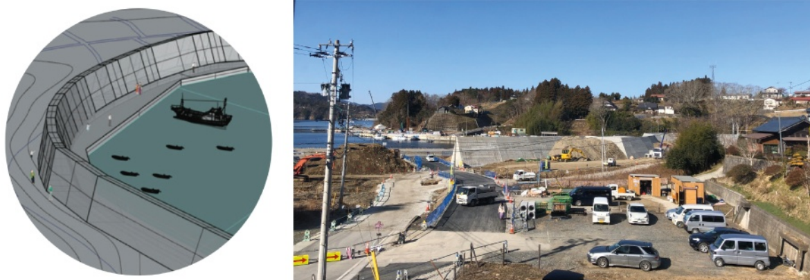
Figura 24 - À esquerda: detalhe do projeto proposto pelo governo de Miyagi para o paredão de 10 metros; à direita: construção do paredão de 8.2 metros em Shībitachi. Fonte: à esq.: Governo da Província de Miyagi, 2011; à dir.: fotografia de Kaori Ito, 2021.
