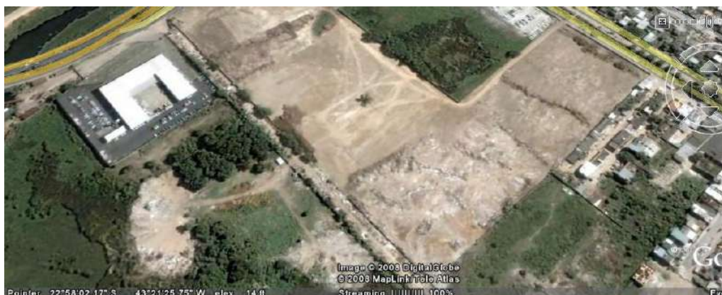
Figura VI.2.4.3: Depósito irregular de RCC entre as Av. Ayrton Senna e Av. Isabel Domingues, Barra da Tijuca – Rio de Janeiro (Fonte: Imagem satélite do programa Google Earth em março de 2008 – LUCERO, 2008)
