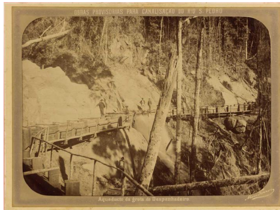
Figura 14 - Marc Ferrez, Obras para melhorar o abastecimento do Rio de Janeiro, 1889.
