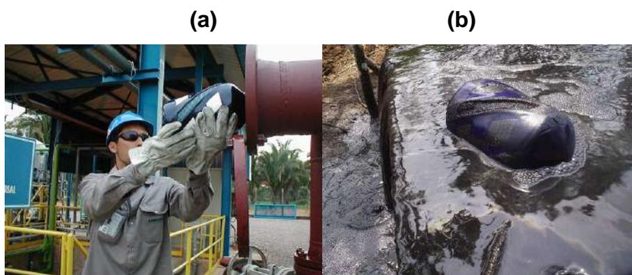
**Figura 3.4: Profissional inserindo o PIG na plataforma de lançamento (a) PIG na saída da tubulação tratada (b) (TNPETRÓLEO, 2011).**
