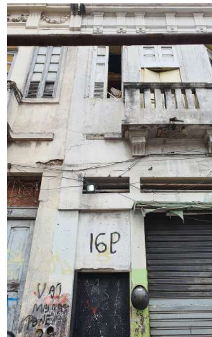
Figura (j) Sobrado localizado no lote 169. A imagem evidencia a presença de pessoas ocupando o imóvel.
