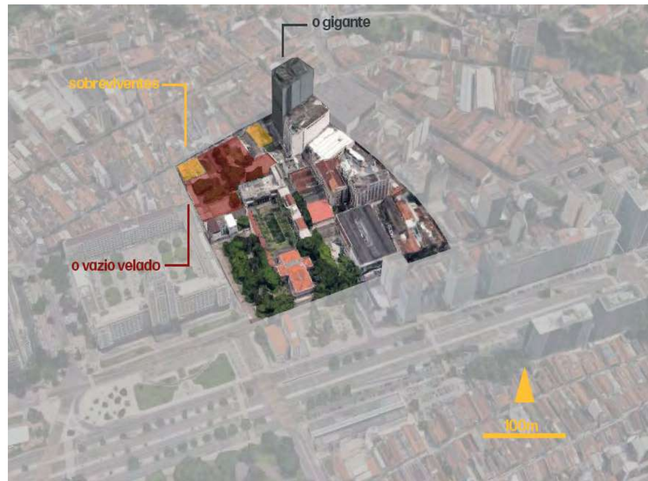
Figura (23) Vista aérea esquemática da quadra com intervenções assinaladas. Fonte: gráfico autoral feito com base em imagem do aplicativo Google Earth.
