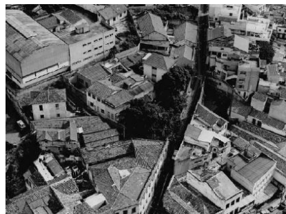
Rua do Livramento, vista aérea.
