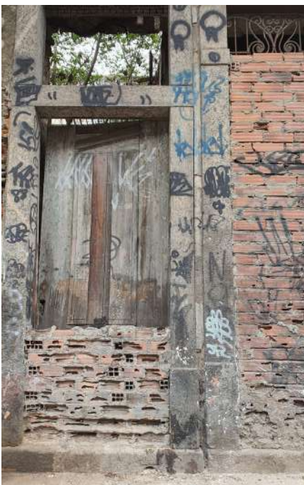
Detalhe da fachada de uma das edificações existentes na área de intervenção.
