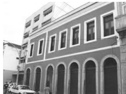
Cortiço requalificado na rua Senador Pompeu.
