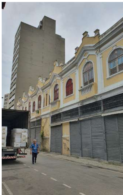
Figura (a) O edifício em primeiro plano na imagem encontra-se na esquina da rua Alexandre Mackenzie com a avenida Marechal Floriano. A construção foi protegida pela APAC-Sagas, e sua fachada apresenta grau de preservação bom. No entanto, encontra-se em desuso.
