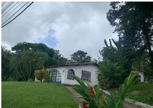
Figura 9 - Casa no bairro ecologia I
