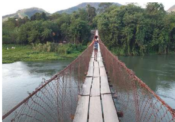
Figura 11 - Ponte entre o Município de Seropédica e o Município de Japeri
