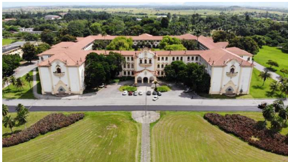
Figura 1 - Prédio principal da Universidade Rural/ P1
