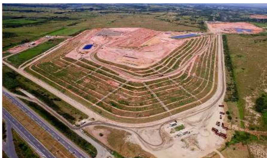
Figura 12: Centro de Tratamento de Resíduos de Seropédica
