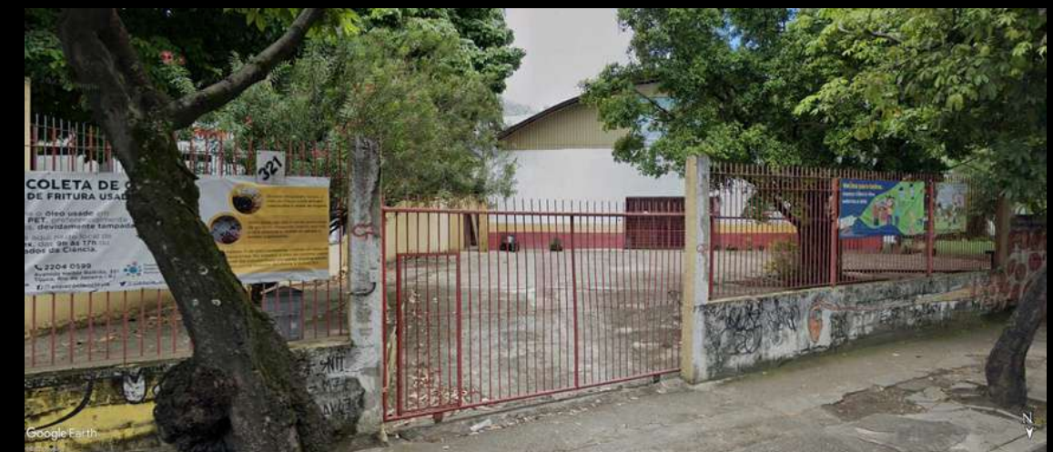
Imagens do terreno. Fonte: Google Street View, 2022
