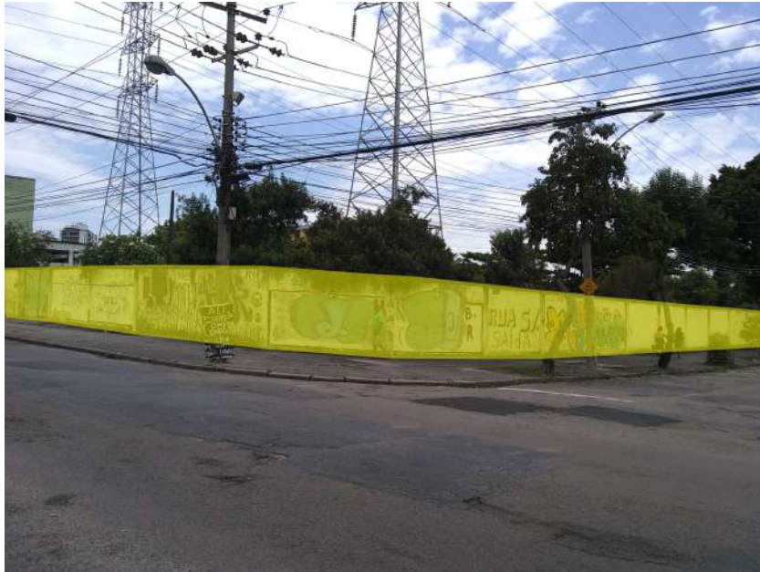
Imagem 24: Muro que limita a linha de transmissão da Light, Rua Frígia. Fonte: Autor, editada pelo autor.
