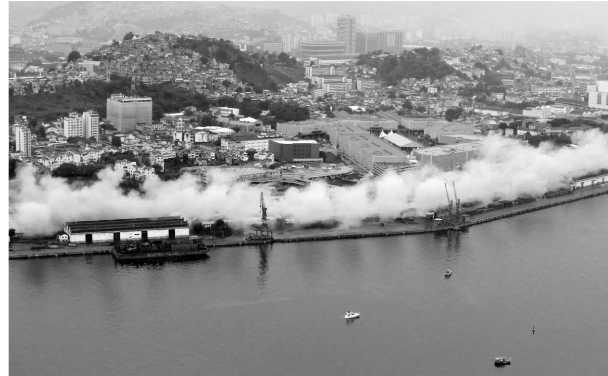
Imagem 14: Implosão da perimetral. Imagem: Folha de São Paulo.
