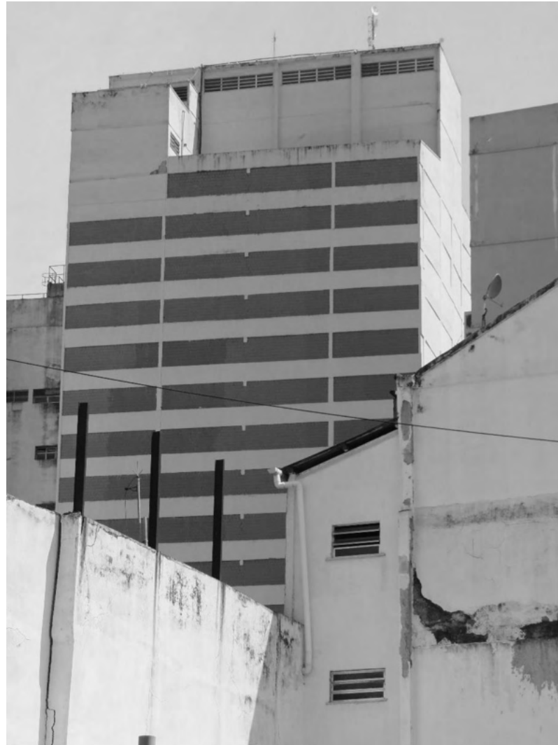
Edifício Garagem Wadih Karabite
