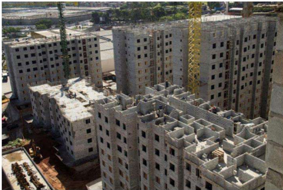
Figura 3 – Alvenaria estrutural em projeto habitacional.
