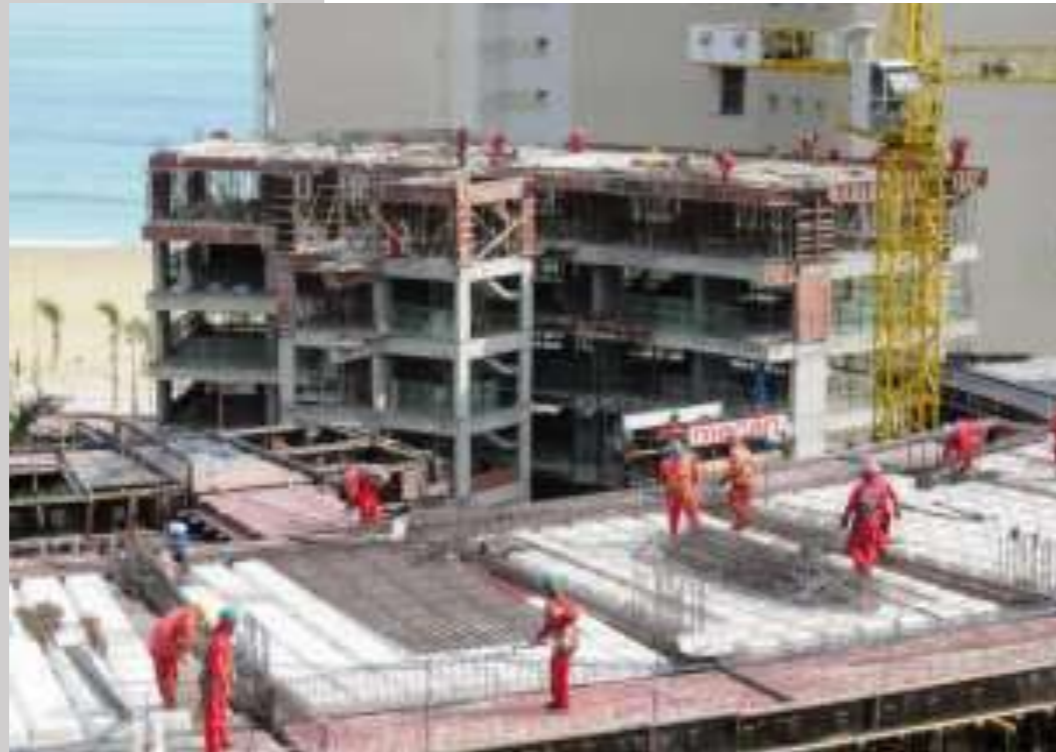
Sistema estrutural em concreto armado moldado no local
