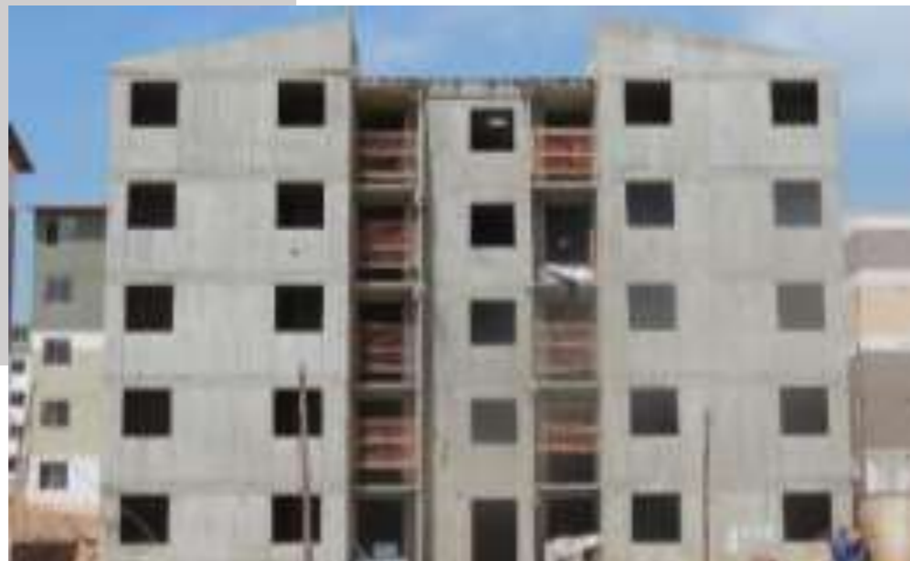
Execução de edificações em paredes de concreto
