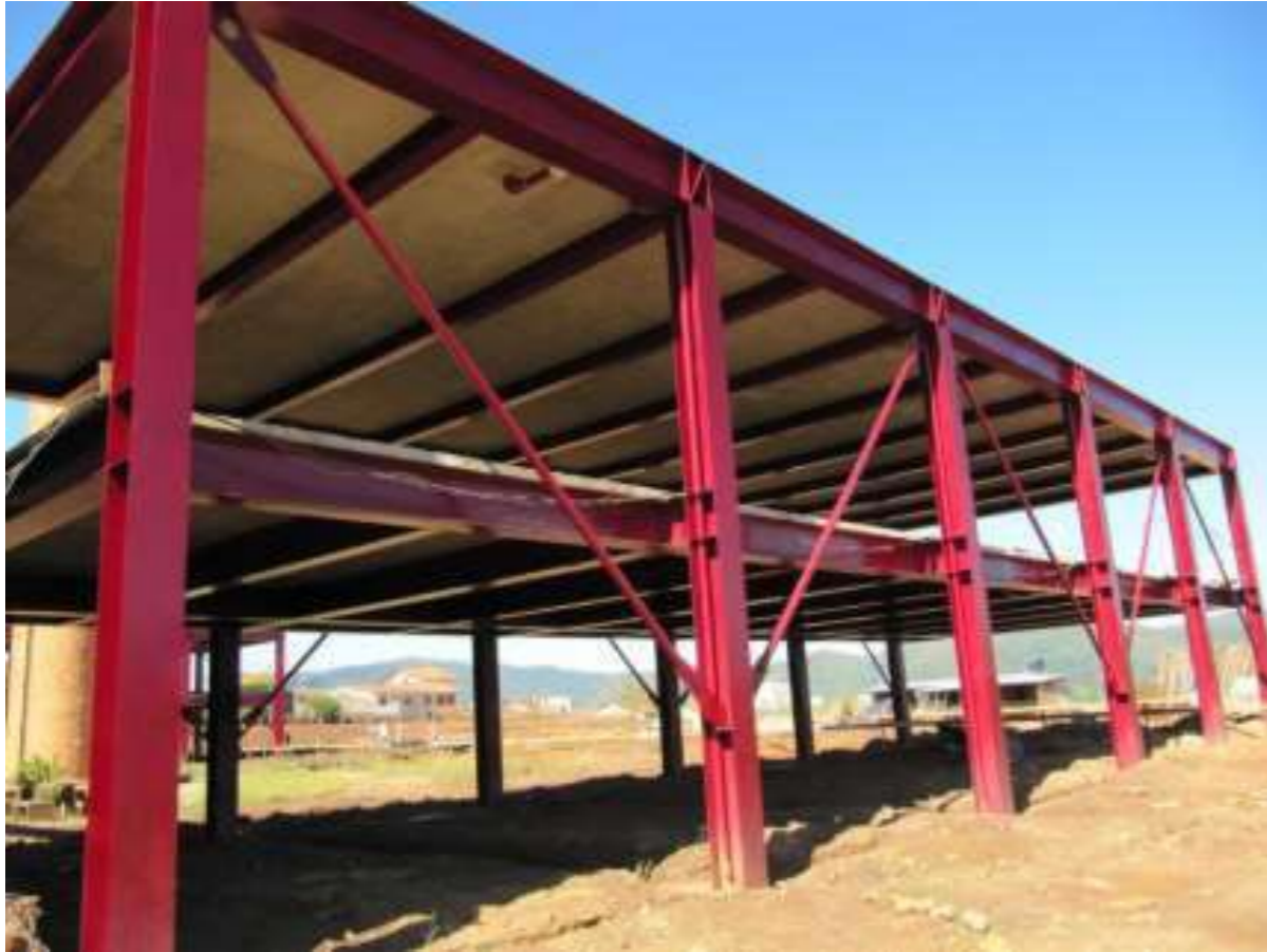
Construção de edificações com sistema estrutural em aço.
