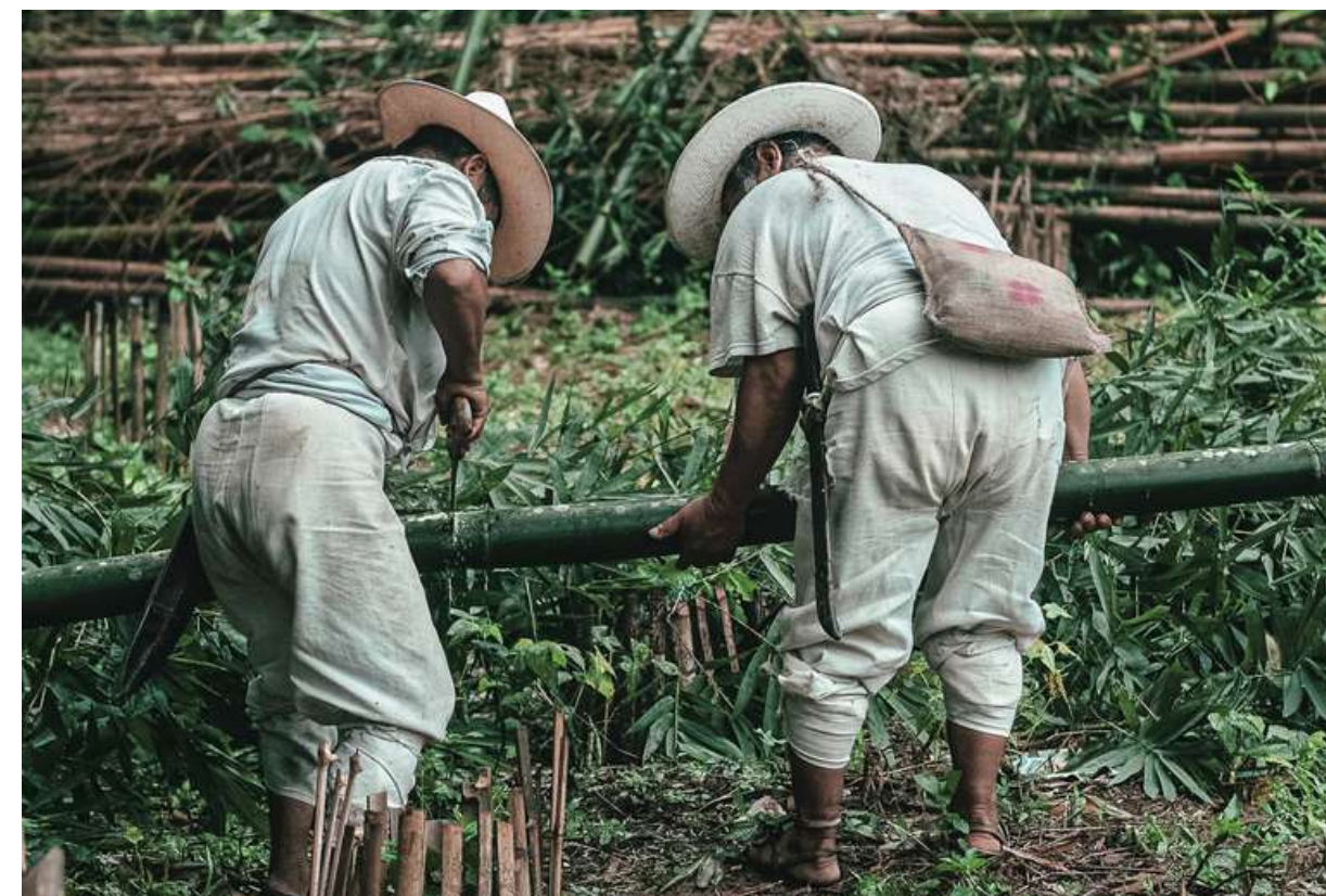
fig 32.: pré-fabricação do bambu no local | fonte: Archdaily
