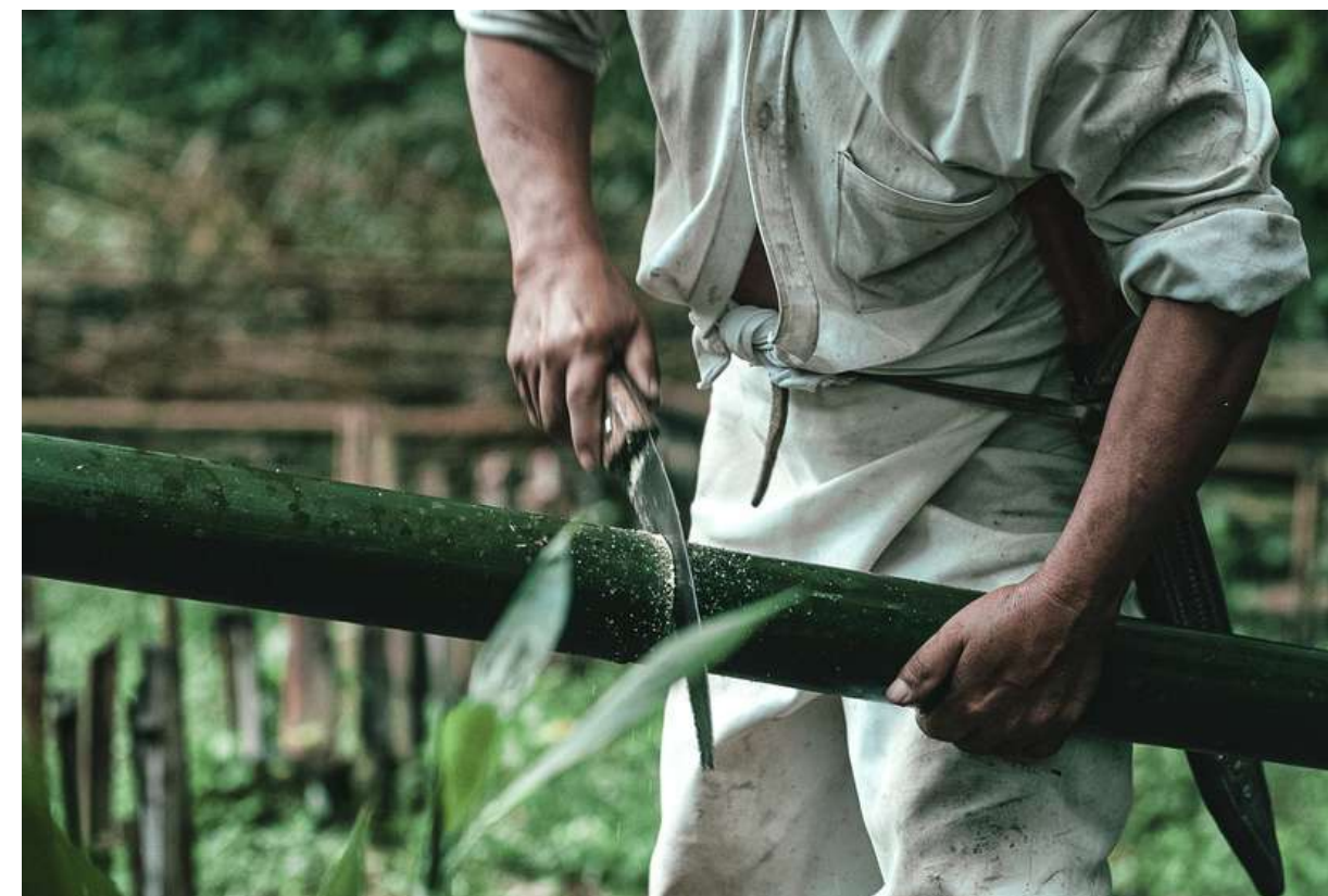
fig 33.: pré-fabricação do bambu no local | fonte: Archdaily
