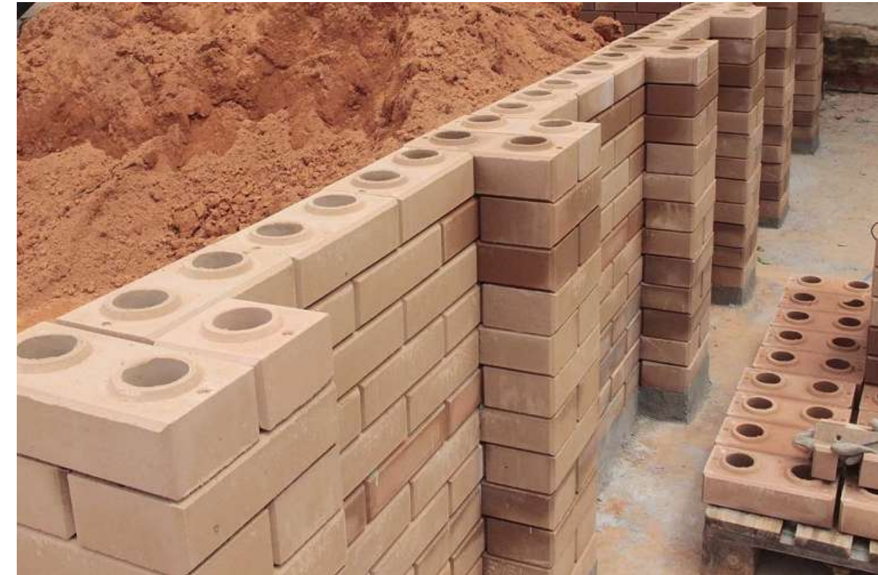
fig 23.: construção em btc | fonte: Google Imagens
