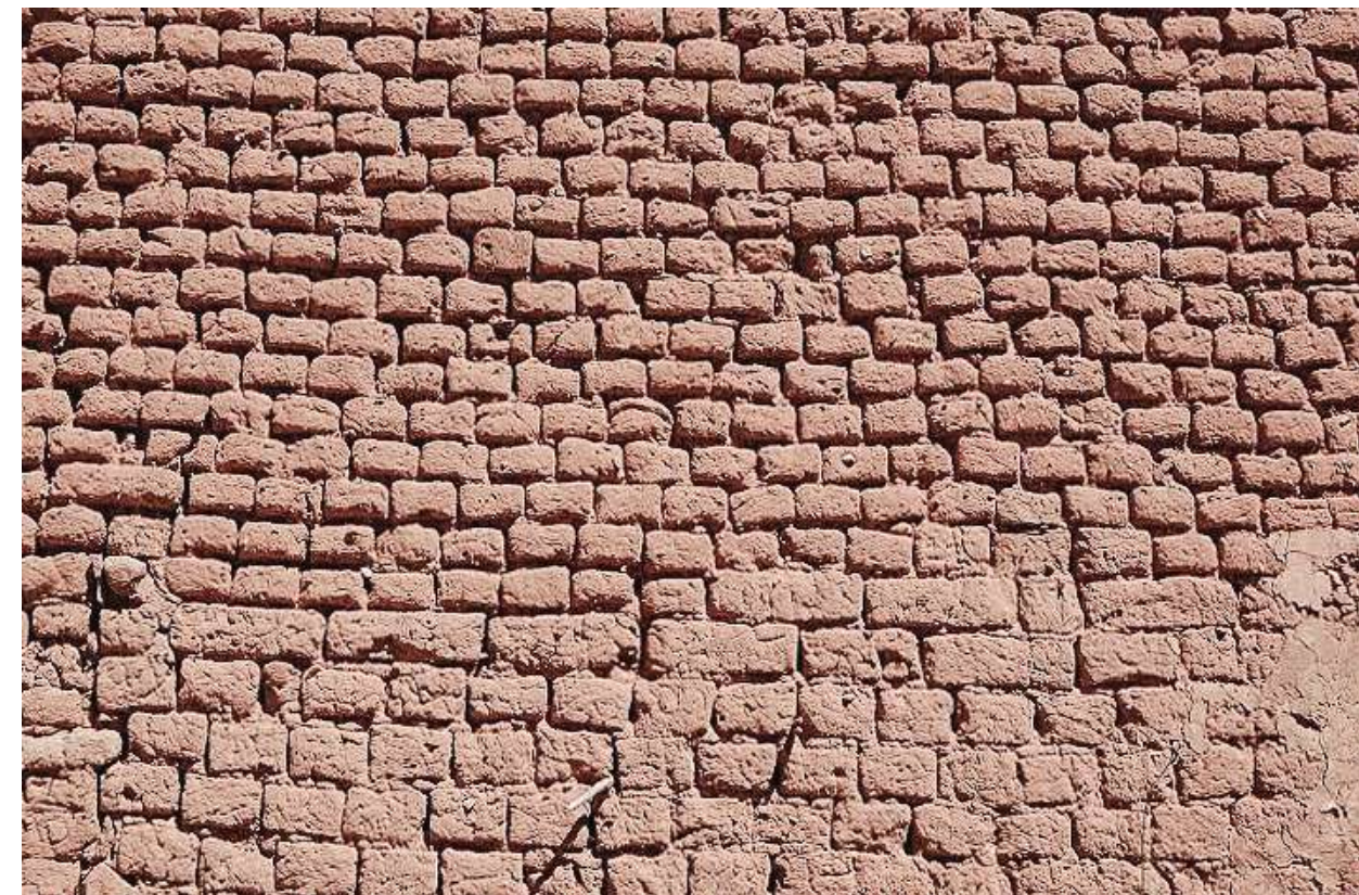
fig 20.: parede de bloco de adobe | fonte: Google Imagens
