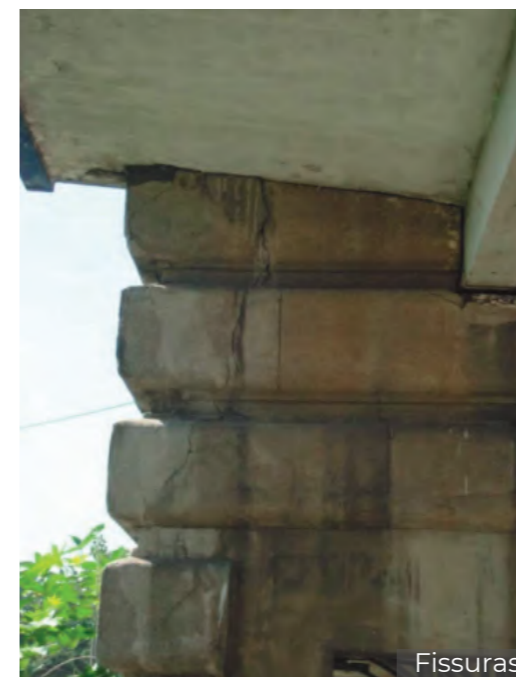
Descolamento do revestimento
