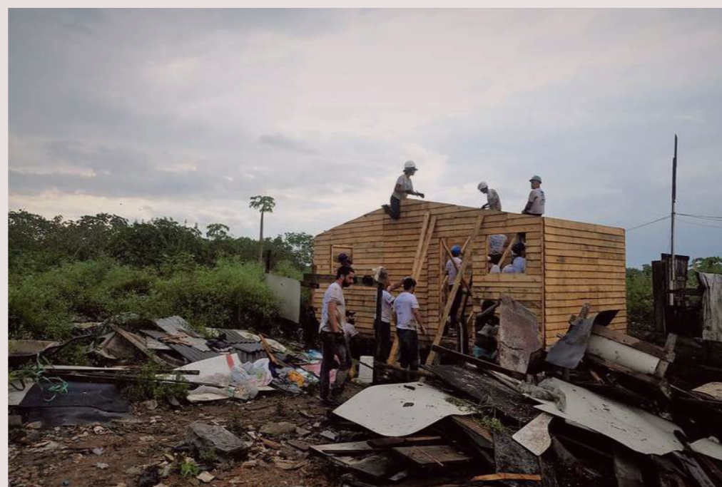
Figura 4-18 Montagem da casa Fonte: ONG TETO. Disponível em: https://www.flickr.com/photos/154063445@N04/ (2018)
