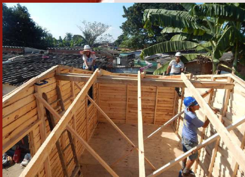
Figura 4-21 Início da fase de aplicação das telhas
