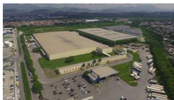
Figura 3.15- Galpão Logístico Fonte: Catena & Castro. Disponível em: https://ccre.com.br/properties/aluguel-galp%C3%A3o-washington-luiz-rio-de-janeiro ( Sem data )
