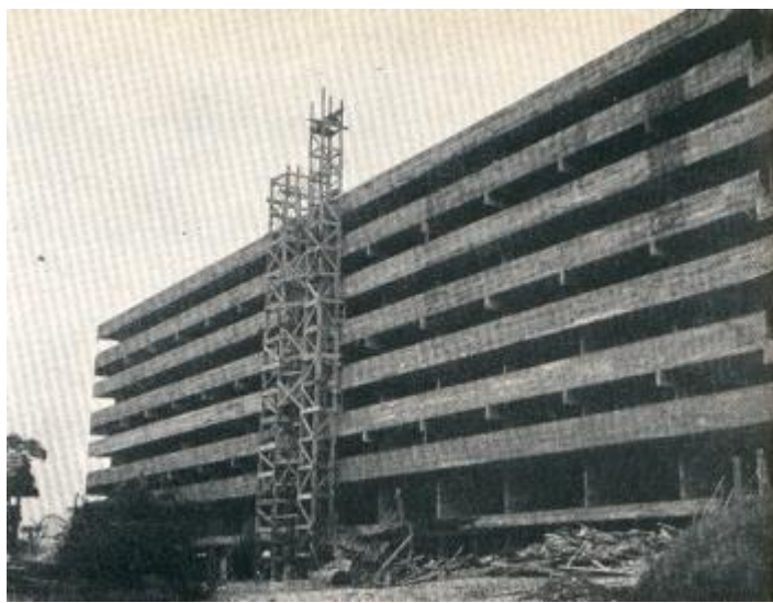
Figura 45: Foto do bloco habitacional do Conjunto de Vila Isabel em construção - FONTE: Revista Municipal de Engenharia, 1956
