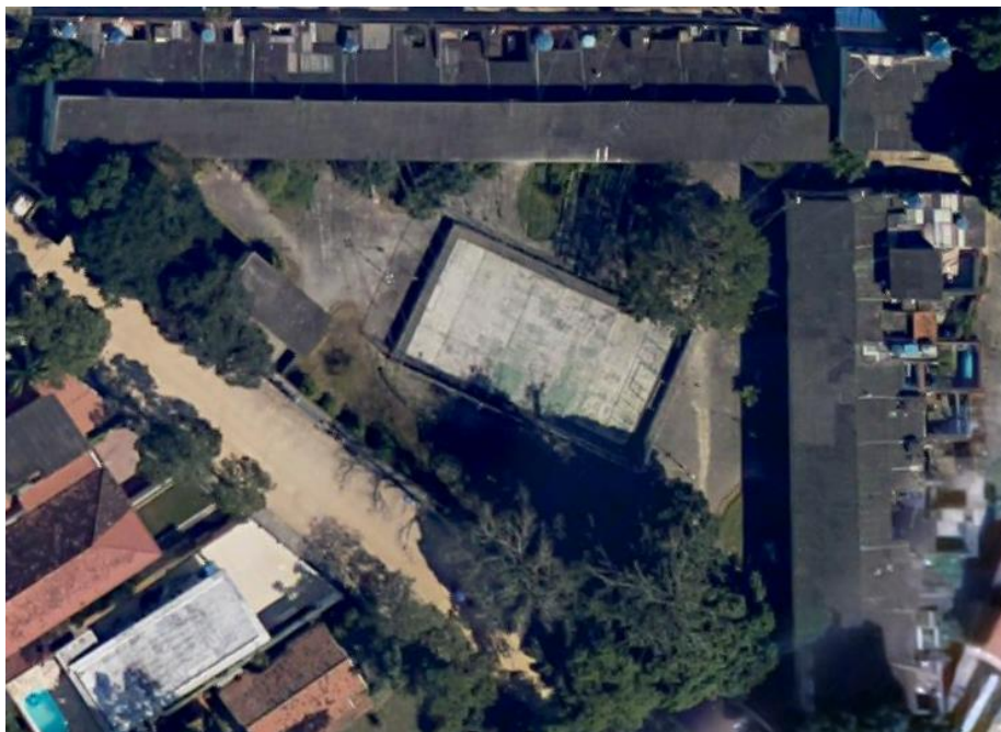
Figura 55 - Conjunto Residencial de Paquetá 2021. Fonte: google earth 10/2021
