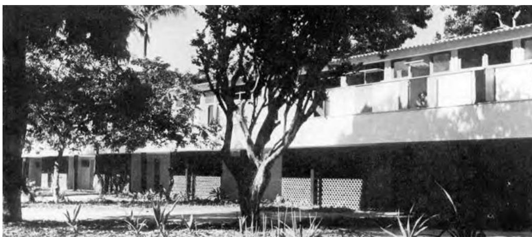
Figura 52: Foto dos sobados do conjunto de Paquetá. Fonte: Arquitetura Moderna no Brasil
