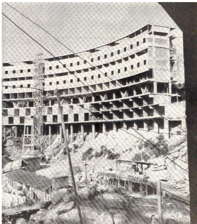
Figura 33: Foto do bloco habitacional do Conjunto da Gávea em construção - fonte: Revista Municipal de Engenharia, 1954
