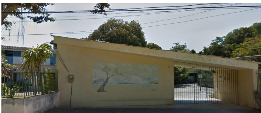
Figura 56 - entrada conjunto residencial de Paquetá 2017. Fonte: google streetview 10/2021
