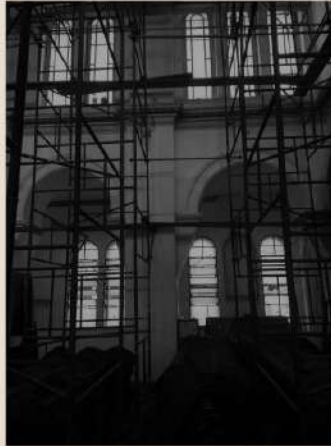
Figura 4a: Arcos e esquadrias semicirculares. Fonte: Autoria própria, 2021.
