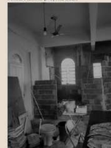
Figura 81: Construção de banheiro e novas instalações no salão comum do térreo. Fonte: Autoria própria, 2021.
