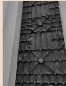
Figura 79: Vedação de esquadria com alvenaria na fachada nordeste da Igreja. Fonte: Autoria própria, 2021.
