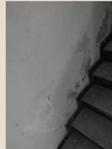
Figura 86: Descolamento de reboco na esquadria. Fonte: Autoria própria, 2021.
