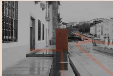
Figura 115: Entrada do Mosteiro de São Miguel de Refojos. Fonte: Archdaily. Editado pela autora, 2021. Disponível em: <a href="https://www.archdaily.com.br/br/548216/restauracao-e-restauracao-do-mosteiro-de-sao-miguel-de-refojos-paulo-freitas-e-maria-joao-marques-arquitetos?ad_source=search&ad_medium=search_result_0th">https://www.archdaily.com.br/br/548216/restauracao-e-restauracao-do-mosteiro-de-sao-miguel-de-refojos-paulo-freitas-e-maria-joao-marques-arquitetos?ad_source=search&ad_medium=search_result_0th</a>. Acesso em: Outubro, 2021.
