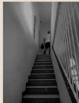
Figura 66: Escada para o segundo pavimento. Fonte: Autoria própria, 2021.
