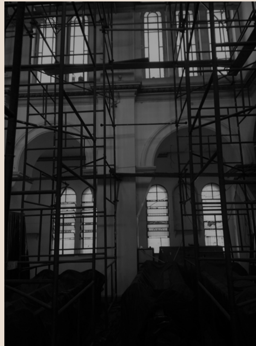
Figura 55: Arcos e esquadrias semicirculares. Fonte: Autoria própria, 2021.
