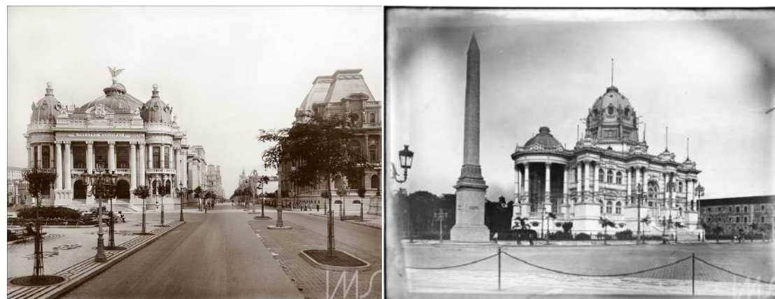
Figura 19: à esquerda, Theatro Municipal e MNBA; à direita, Palácio Monroe e obelisco da Avenida Central. Fonte: Instituto Moreira Salles
