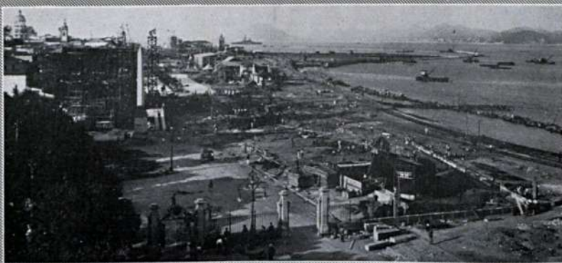
Diversos aspectos actuaes das obras no recinto em que vai funcionar a grande Exposição Internacional.
