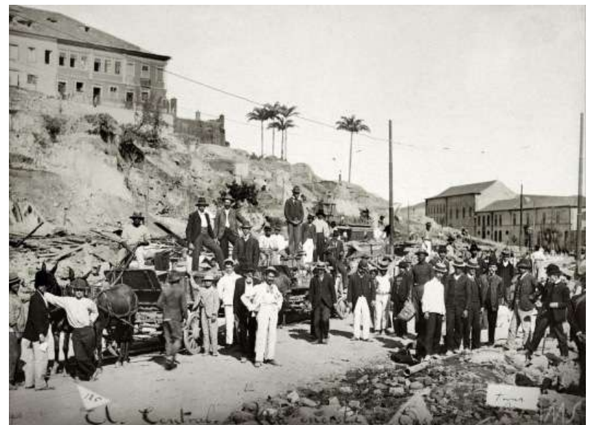
Figura 17: Demolição de parte do Morro do Castelo para a abertura da Avenida Central. Fonte: Instituto Moreira Salles
