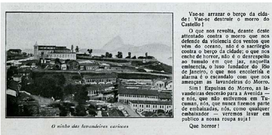
Figura 23: Crônica da Revista Careta, ironizando a demolição do Morro. Fonte: Revista Careta (1916)
