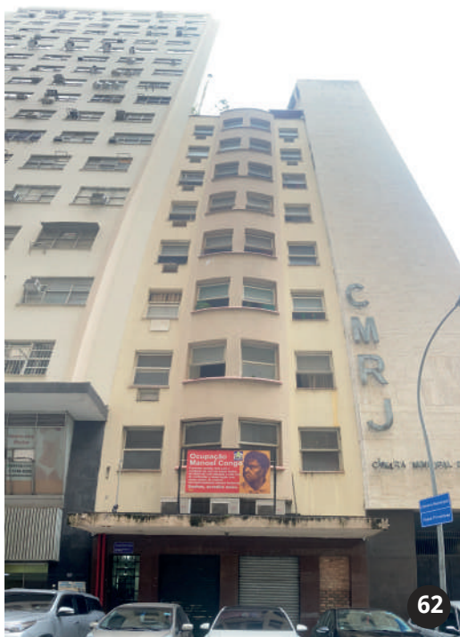
Figura 62 - Fachada da Manoel Congo, a partir da Rua Alcindo Guanabara. Observa-se que a fachada da Ocupação quase se confunde com a fachada da CMRJ.
