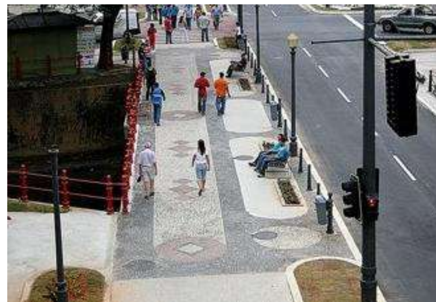
Imagem rua do Imperador após conclusão das obras [140]
