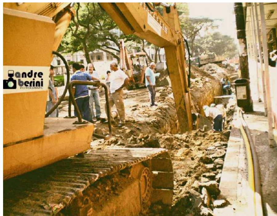
Imagem rua do Imperador em obra para extensão de calçada [139]
