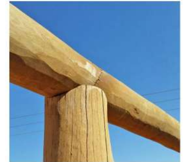
ENCAIXE ENTRE VIGAS E PILARES
