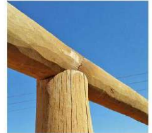
ENCAIXE ENTRE VIGAS E PILARES
