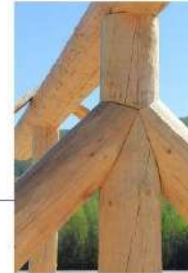
ENCAIXE ENTRE VIGAS E PILARES
