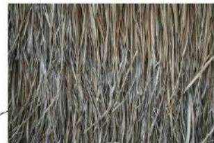
COBERTURA: PALHA DE PIAÇAUA
