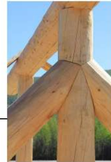
ENCAIXE ENTRE VIGAS E PILARES
